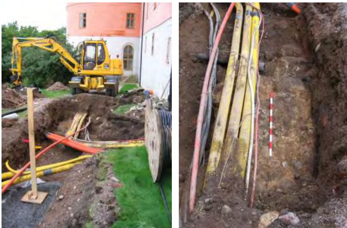
Figur 12 och 13. Murresten A5 schaktas fram, foto mot söder. I bakgrunden ses slottets södra torn. Högra fotot visar den kalkbruksbemängda murresten som täckts med ledningar. I sektionen skymtar även brandlagret som troligen är från branden år 1572. Foton Anna Ölund, Upplandsmuseet.
