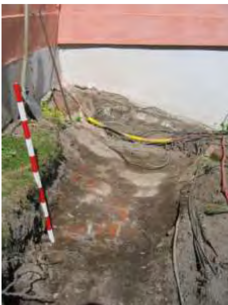
Figur 3. A1, ett skadat murparti invid slottets norra torn och långslottet (till vänster i bild). Foto mot VNV av Linda Qviström, Upplandsmuseet.
