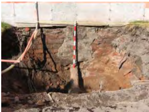
Figur 4. A2, parti av långslottets källarmur. Schaktet grävdes för att avloppsledningen som syns på bilden skulle bytas ut. Närmast till höger om avloppsröret syns de tre tegelskift som var murade utanpå den övriga muren. I schaktväggen till höger om detta syns rasmassor under matjorden. Foto mot väster, Linda Qviström, Upplandsmuseet.
