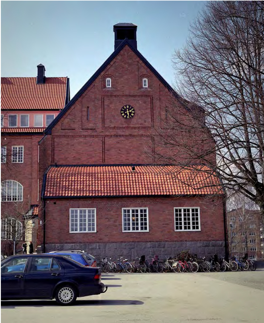
Nordöstra flygelns fasad mot skolgården, med kollegierummets fönster i bottenvåningen och gavelparti mot aulan.
