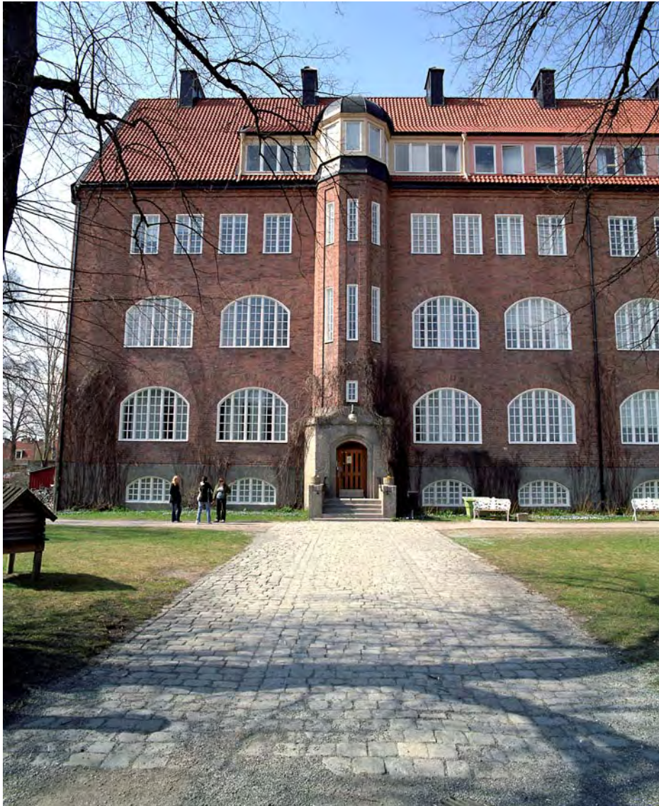
Huvudbyggnadens fasad mot skolgården, utanpåliggande trapphus med fd växtrum samt utbyggd vindsvåning.
