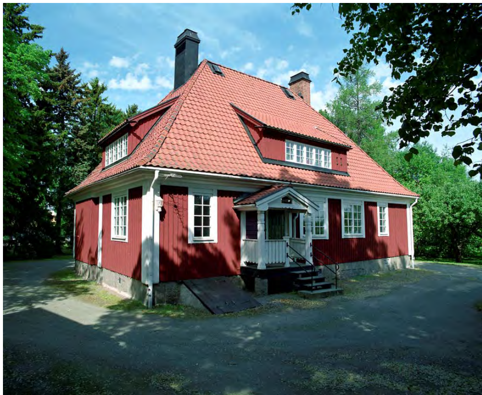
Den fd vaktmästarbostaden, fasad mot Ö med förstukvist och källarnedgång. Foto: Lennart Engström, Upplandsmuseet 2006
