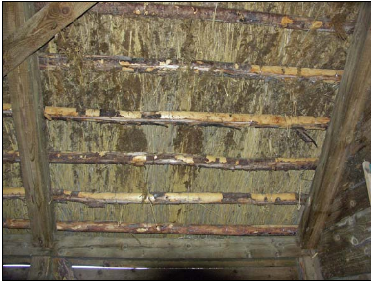
Takets insida efter omläggning. Vassen har styrts så att den inte sticker ut genom slanorna genom att en masonitskiva lagts ovan slanorna under stötningen.
