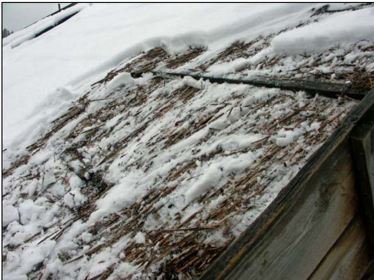
Sydöstra takfallet innan rivning. Vasstaket är i så dåligt skick att den tidigare dolda bindläkten har exponerats och fått omfattande rötskador.
