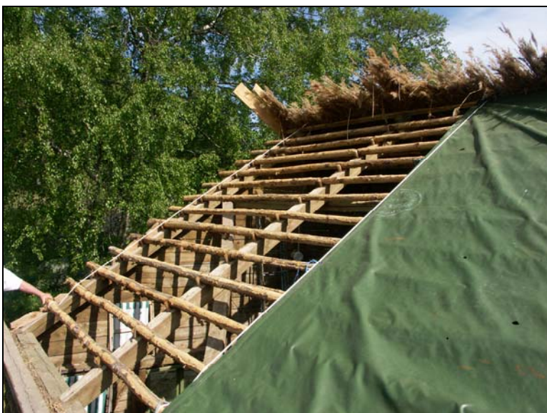
Nordvästra takfallet med avlägsnad vasstäckning. De längsgående granslanorna, som hålls på plats av träpliggarna i sparrarna, är i gott skick och behöver inte bytas.
