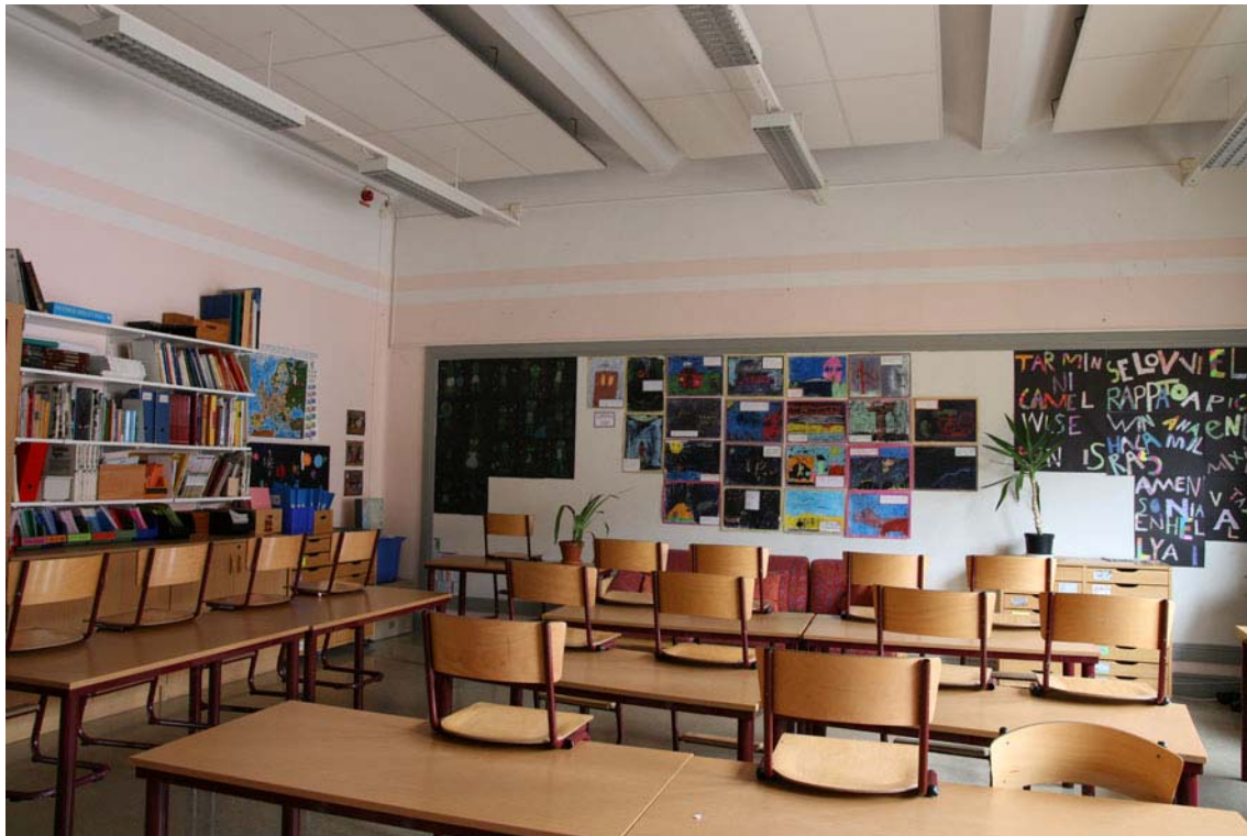
Klassrum i hus 1. Akustikplattor i taket skymmer takvalven. På väggen finns ramverket till den gamla svarta tavlan kvar.
