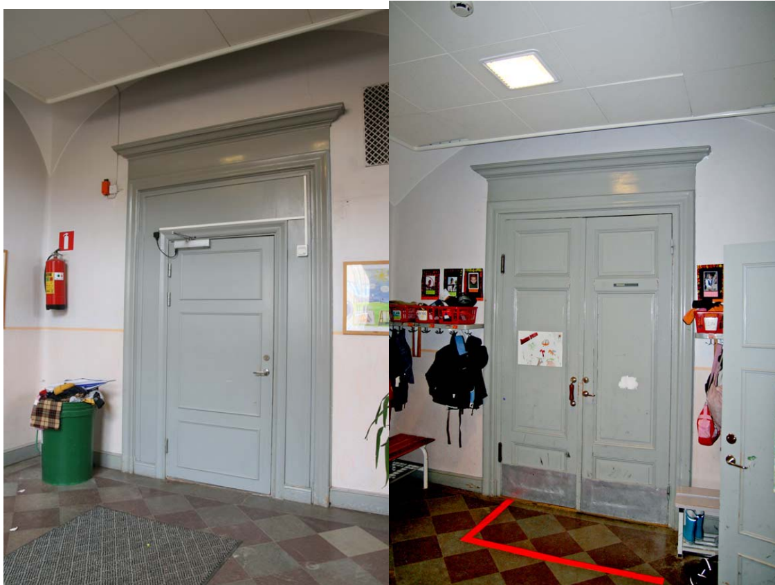
Påkostade dörrpartier i trapphuset till hus 1 med profilerade foder och överstycken. Till vänster har en mindre dörr satts in, till höger syns ursprunglig dubbeldörr. Akustikplattor i tak skymmer kryssvalvet.
