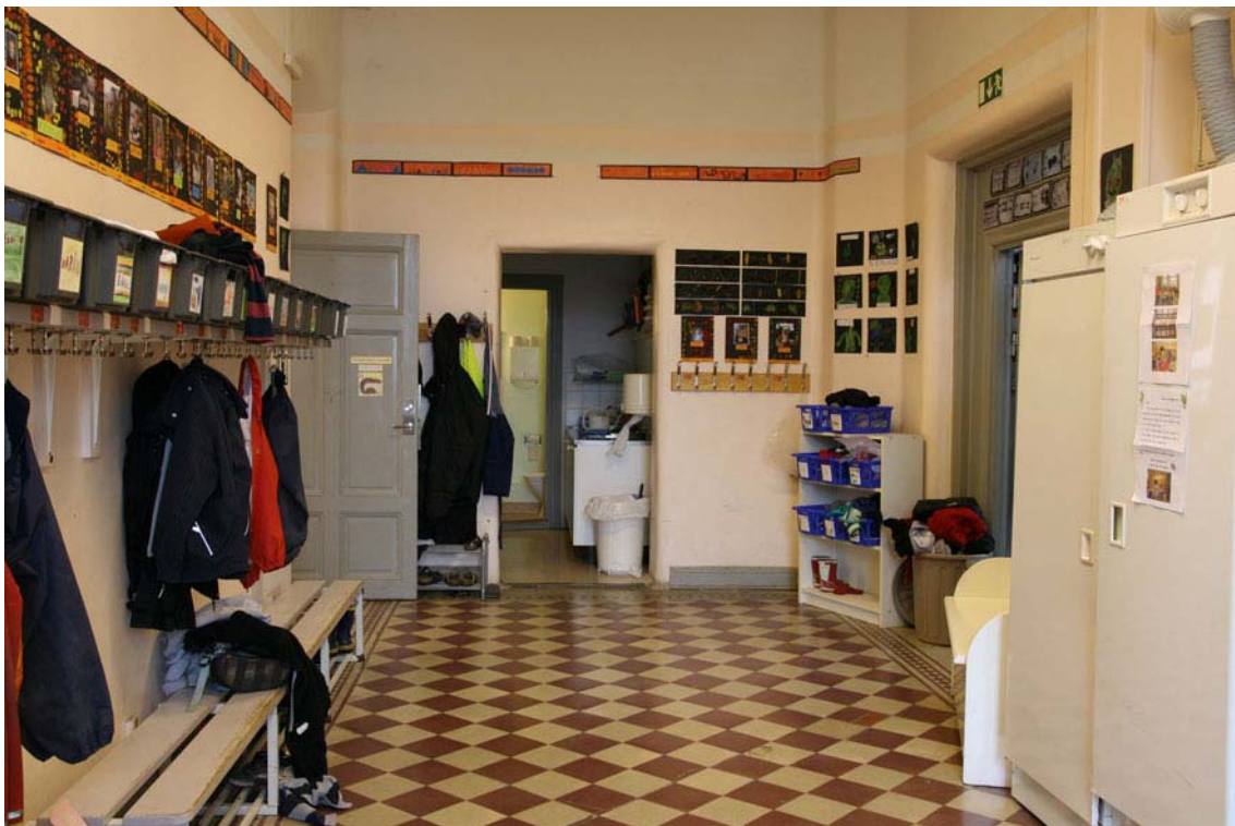
Kaprummen i hus 1 har bevarat ursprunglig golvbeläggning med mönsterlagda keramiska plattor.
