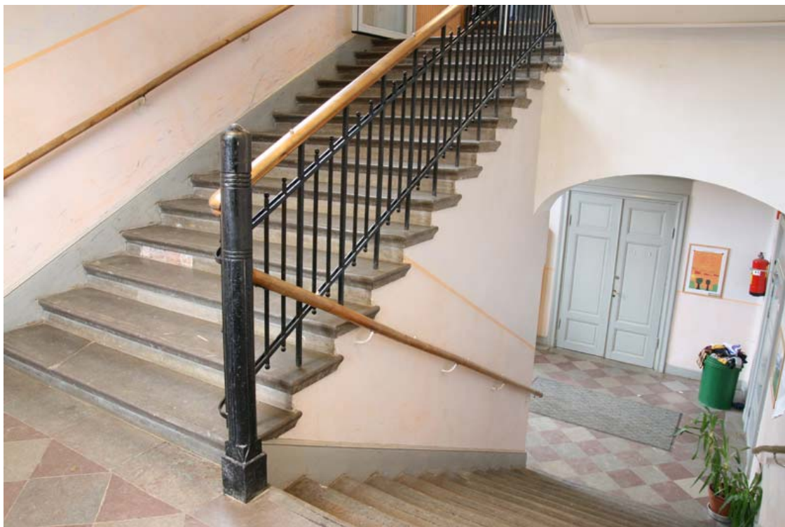
Trapphusen har gedigna material. Trappräckena är utformade i jugendstil.
