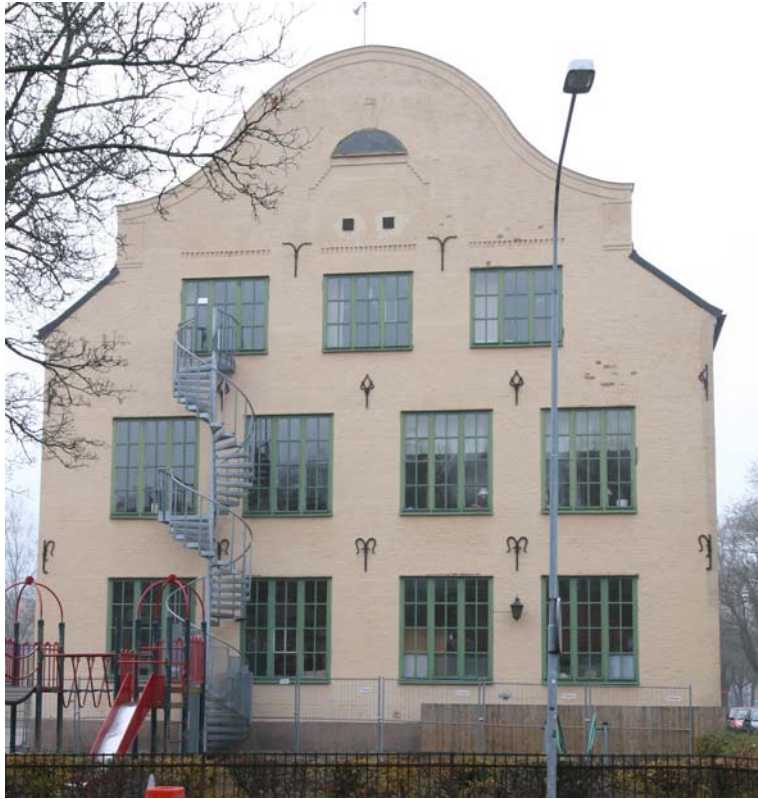
Gavelfasaden mot Syslomansgatan på hus 2, annexet.
