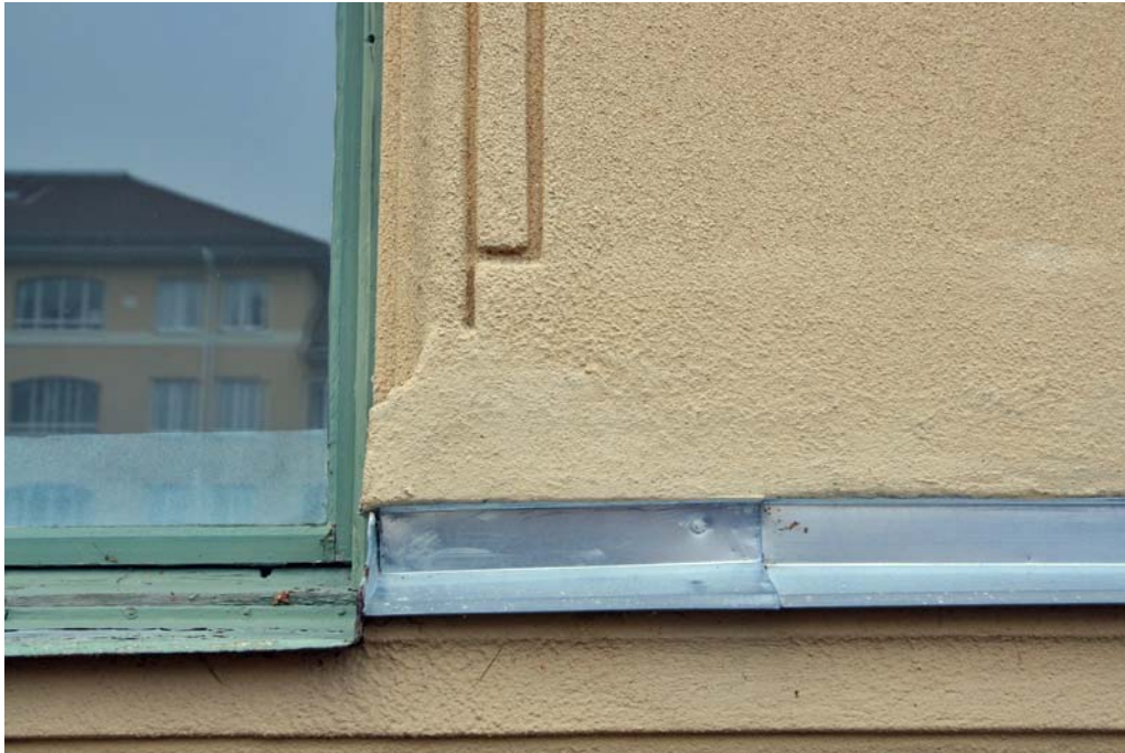
Ny plåtavtäckning på putslist i traditionellt utförande med galvaniserad plåt. Den nuvarande stänkputsen har en grov yta som gör att den ursprungliga detaljeringen och skärpan i arkitekturen delvis försvunnit.
