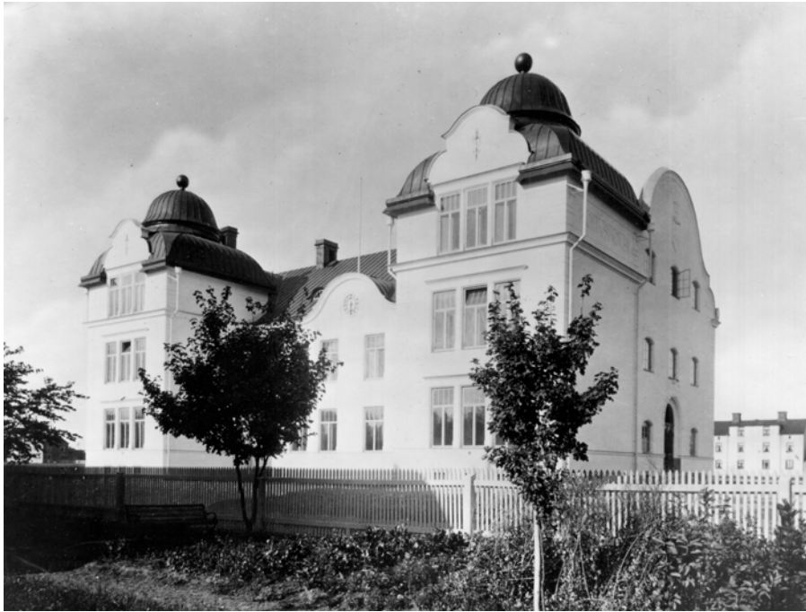
Sverkerskolan från Tegnérgatan, foto av Alfred Dahlgren omkring 1906. Här ses hur de ursprungliga fönstren såg ut.
