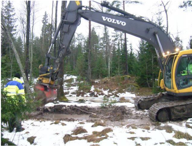
Figur 11. Schaktning intill den röseliknande stensättningen, nr 32 (jfr fig 5). Stensättningen kan anas i bildens mitt
