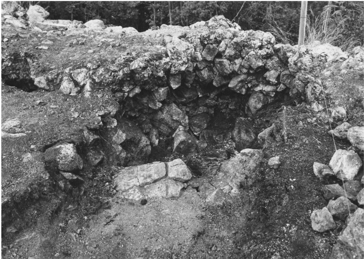
Figur 14. Kopia av svart/vitt foto. Del av den "stenkista" i murkrönet som grävdes fram i samband med undersökningen. De grövre stenarna i botten utgör en del av murens fundament. Okänd fotograf.
