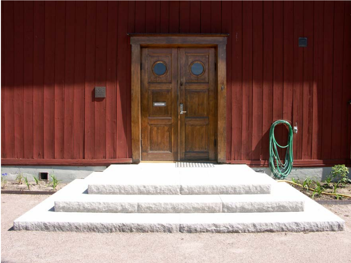
Ny trappa i Bjärlövgranit, 2009
