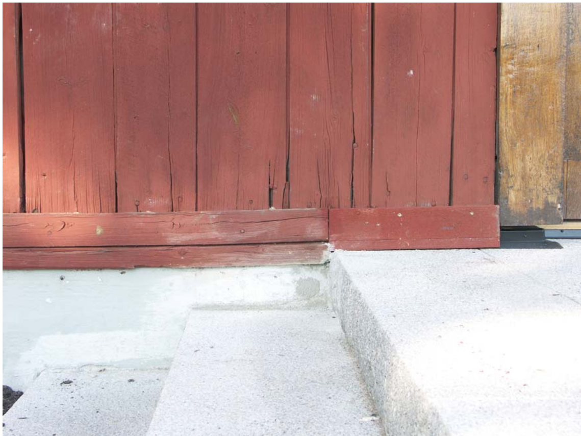
Putsad sockel efter åtgärder, 2009
