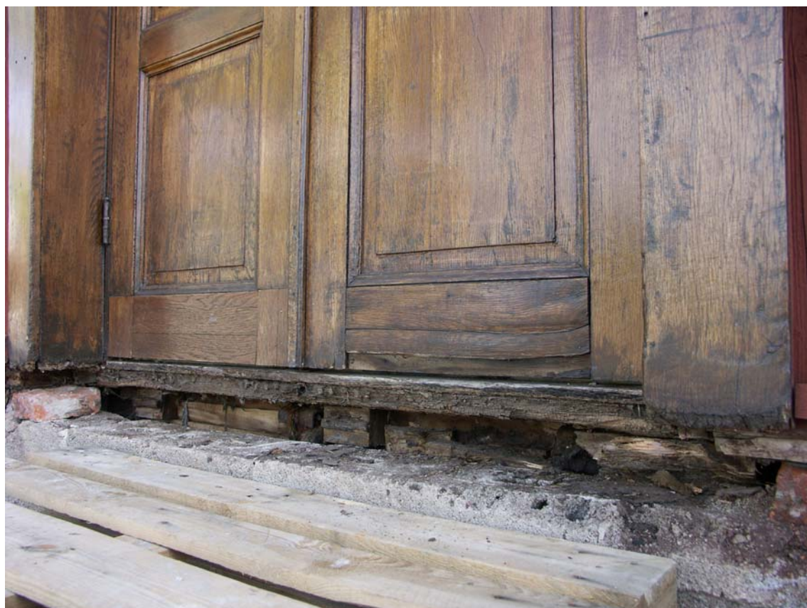
Rötskador i tröskel, klossning till tröskel, dörrfoder och dörrbladets nedre del, 2009
