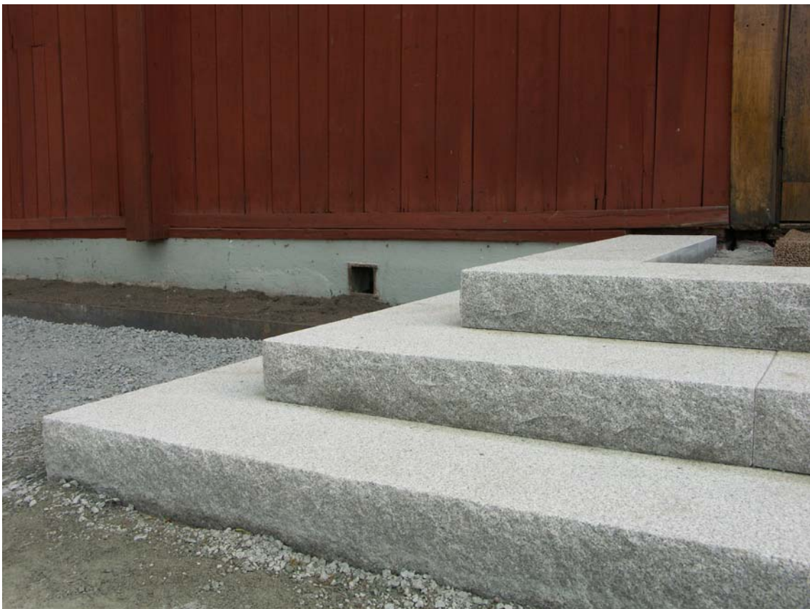
Ny trappa i Bjärlövgranit, 2009
