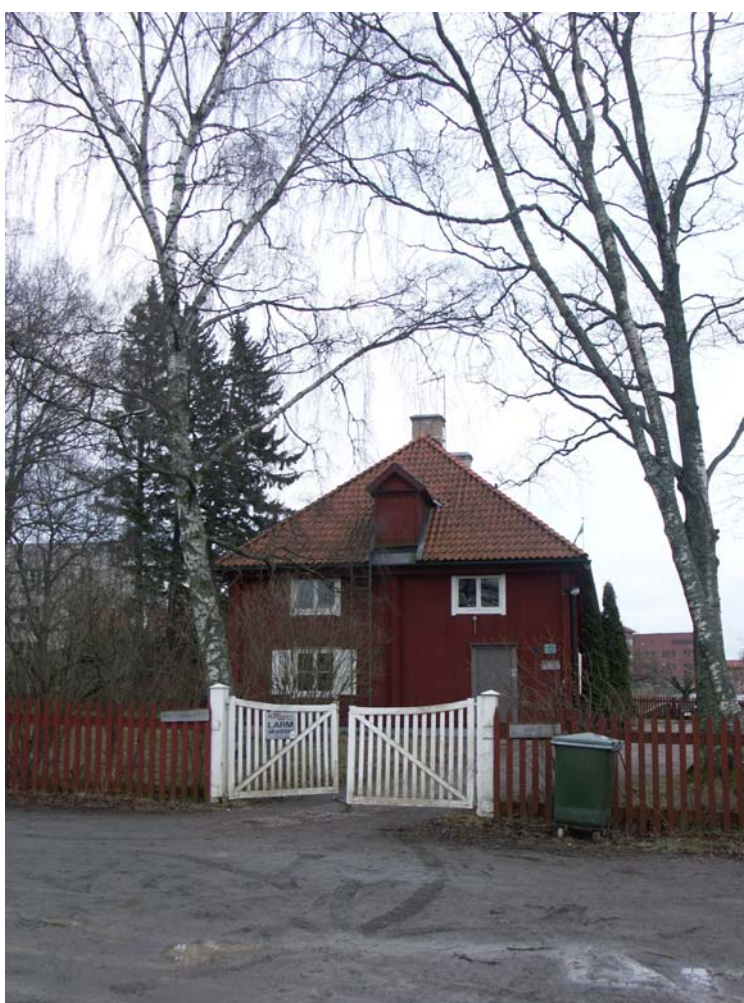
Entrégrind mot nordväst, rötskadade björkar, 2008
