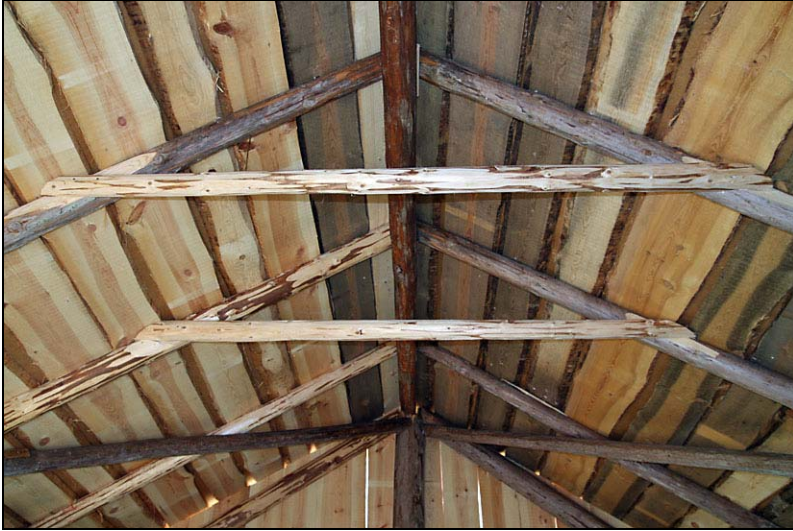
Återlagt och kompletterat taklag med bindslanor och underbrädning av okantade bräder
