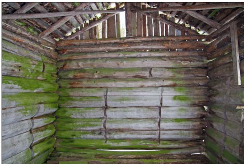
Urtag i den norra gavelväggen respektive långsidornas norra del visar både hur byggnaden tidigare balkats av och hur golvnivån tidigare varit.
