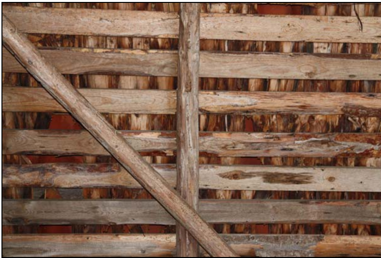
Undertak med klensparrar, utskottsbräder och två eller trelagers hyvlade stickspån
