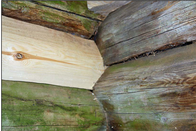
Insidan av hörn C/D med den nytimrade stock C8.
