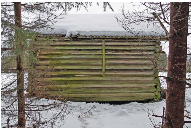
Fasad mot väster. Tumstocken på väggen är 120 cm i längsled och 80 cm i höjdled.
