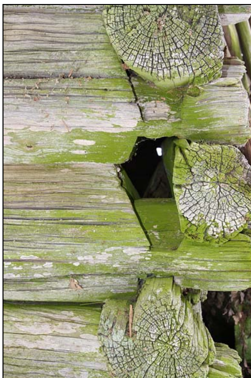
Detalj av knutkedja med sneda hak och mittröskel.
