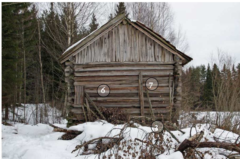
Vägg B (söder)
