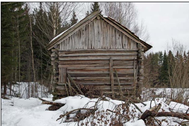
Fasad mot söder. Tumstocken på väggen är 120 cm i längsled och 80 cm i höjdled.
