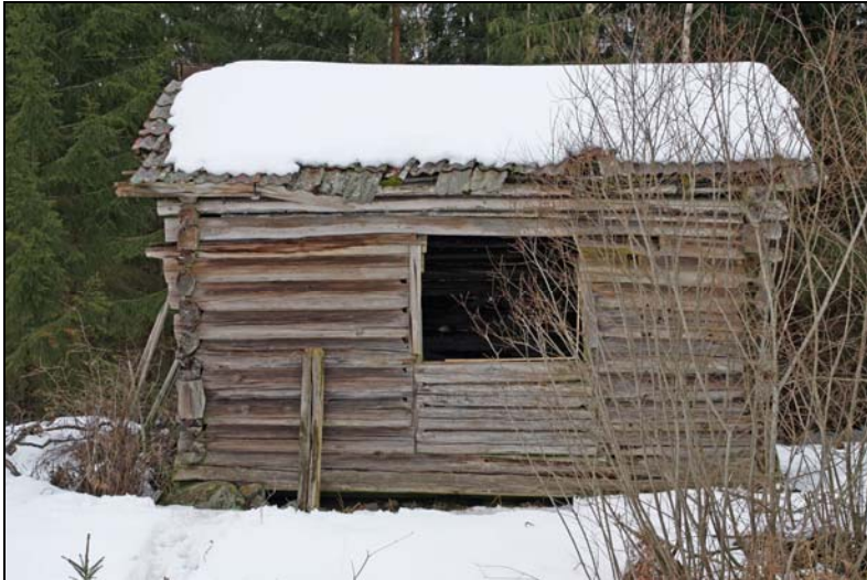
Fasad mot öster. Tumstocken i öppningen är 120 cm i längsled och 80 cm i höjdled.
