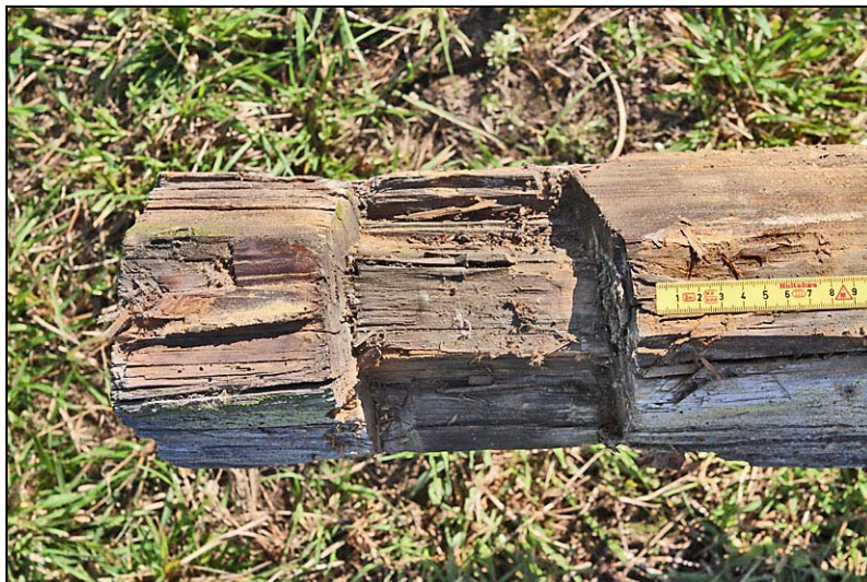
Knut från ovansidan med tröskel placerad mitt i överhaket
