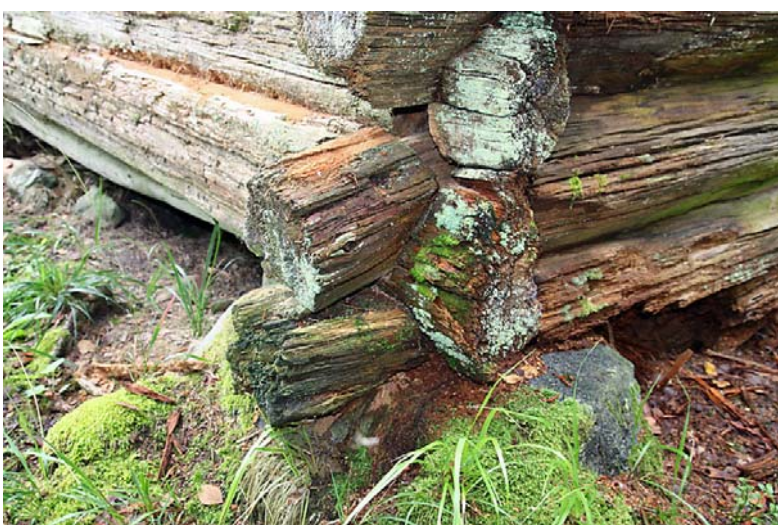
Knut C/D med kraftigt rötskadad syll. C2:s knutskalle är av.
