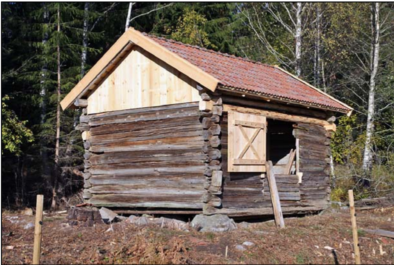
Byggnaden efter slutförd restaurering.
