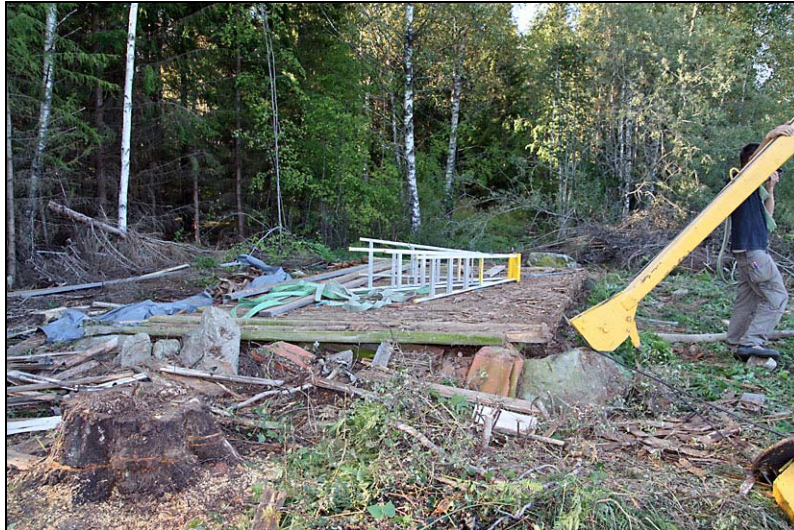
Demonterad stomme. Det friliggande golvbjälklaget ligger fortfarande kvar på plats.
