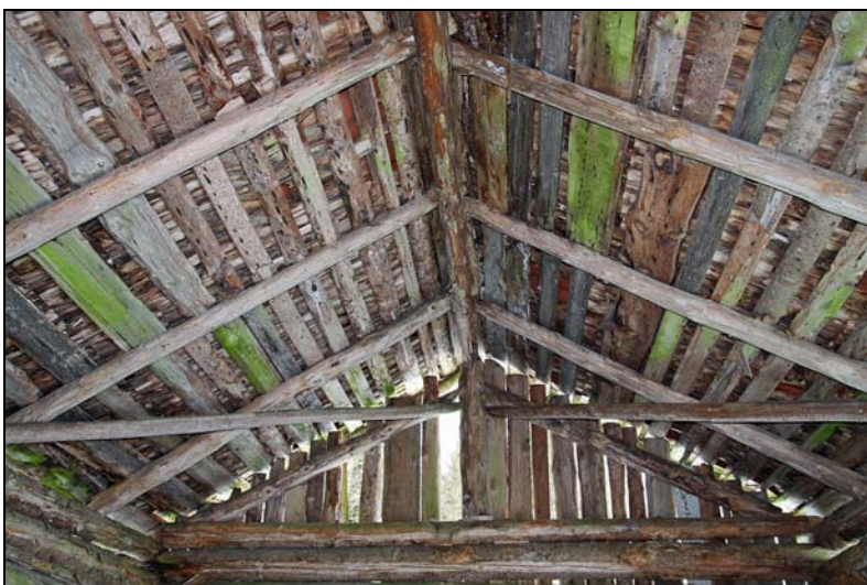
Takets konstruktion med kroppsbärande stolpe med stödjande snedsträvor.
