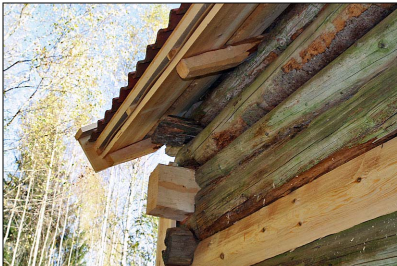
Takfot vid hörn C/D med ny sparre, underbrädning, masonit, ströläkt och bärläkt.
