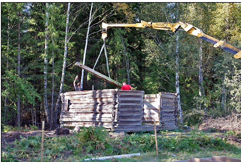
Byggnaden under demontering. Byggnadsdelarna märktes upp för senare återmontering.
