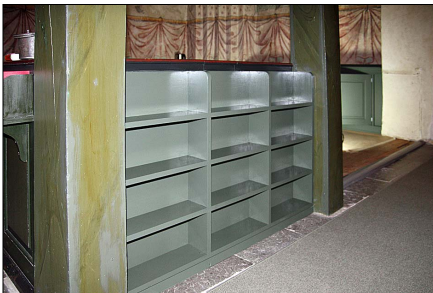
Under södra delen av läktaren. En fast psalmbokshylla har byggts mot mittgången. Hyllan har grundmålats.
