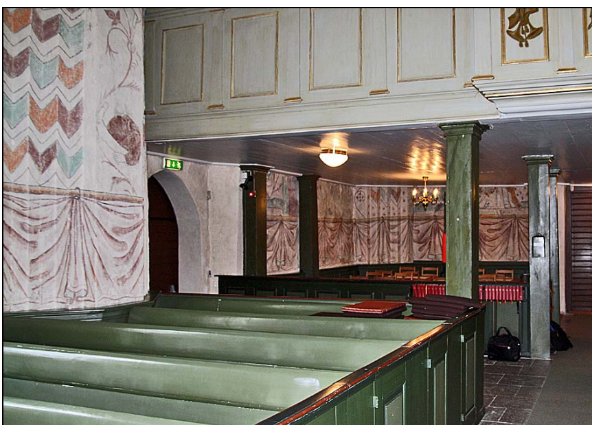
Under södra delen av läktaren efter ändringarna.
