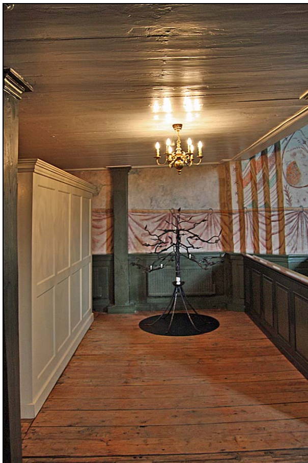
Det tillskapade andaktsutrymmet efter arbetena. Utrymmet avgränsas av den nya skärmväggen i väster och den nya bänkkfronten till bänkkvartern i öster. Utrymmet är försett med en ljuskrona.
