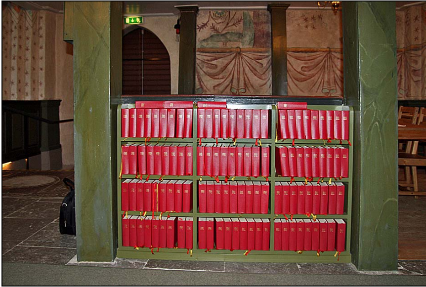
Psalmbokshyllan efter slutförda arbeten. Hyllan har målats på samma sätt som omgivande snickerier.
