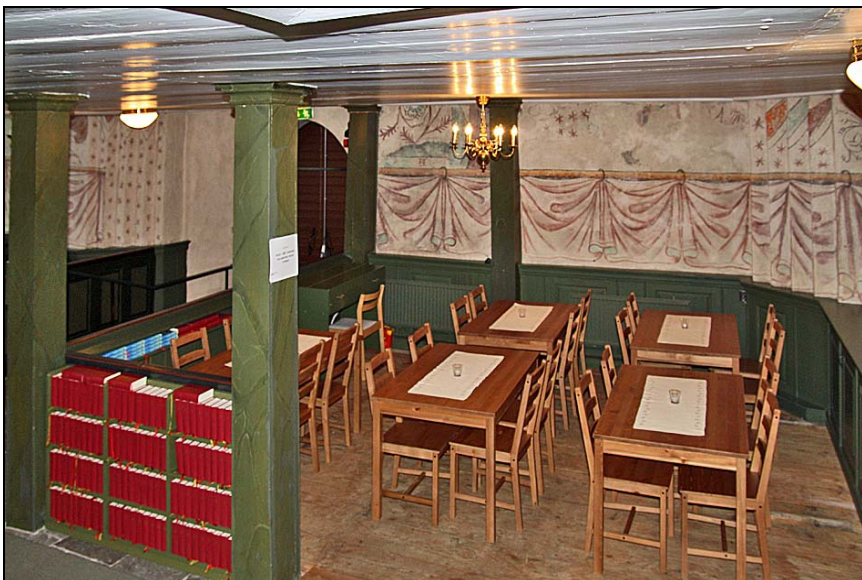
Under södra delen av läktaren efter ändringarna. Kyrkbänken mot västväggen har ersatts av en låg bänk som målats in på samma sätt som omgivande snickerier. Kyrkbänken i utrymmets östra del har demonterats. Styrpulpeten har flyttats mot utrymmets sydöstra hörn. Utrymmet belyses av plafonder och en krona.
