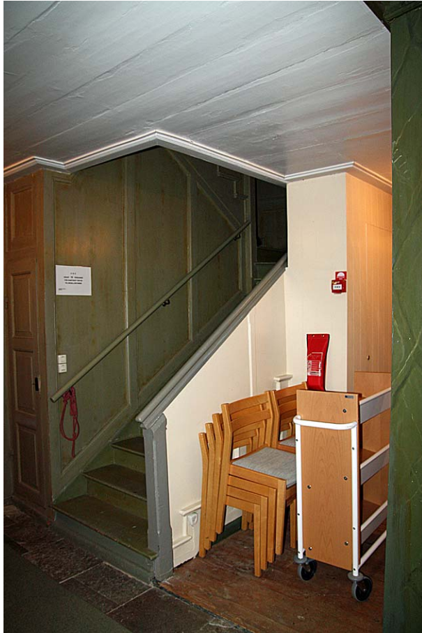
Utrymmet vid trappan efter avslutade arbeten.
