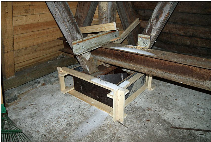
Formsättning av ny plint för hörnstockarna. Stockarna är fixerade efter flytten och inför ingjutningen med bulvförband och stålbalk.
