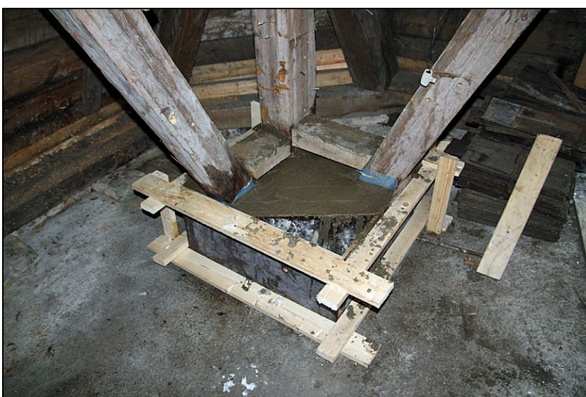
Gjutning av plint för hörnstockarna. Stockändarna är isolerade med papp.
