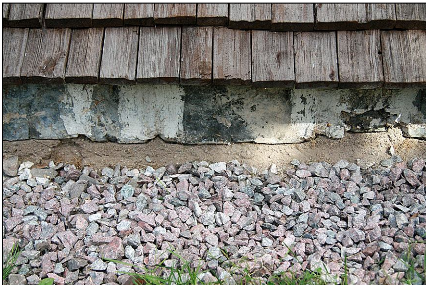
Grundens betongplatta täcks av slaggsten och den omgivande marken är grustäckt.
