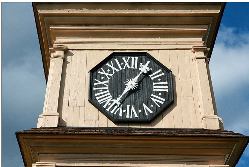
Urtavla efter reno- vering. Visarna har blåstrats rena från rost, rost- skyddsbehandlats och slutstrykts med bruten vit linolje- färg.
