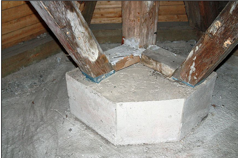
Färdig plint för hörnstockarna.
