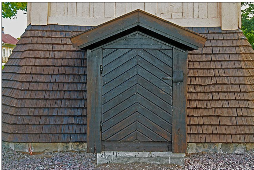
Förstugan och kjolen efter restaurering. Spåntäckningen har kompletterats och lagats och tjärstrykningen har förnyats..
