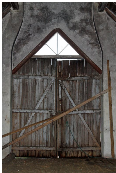
Port till södra körbron
