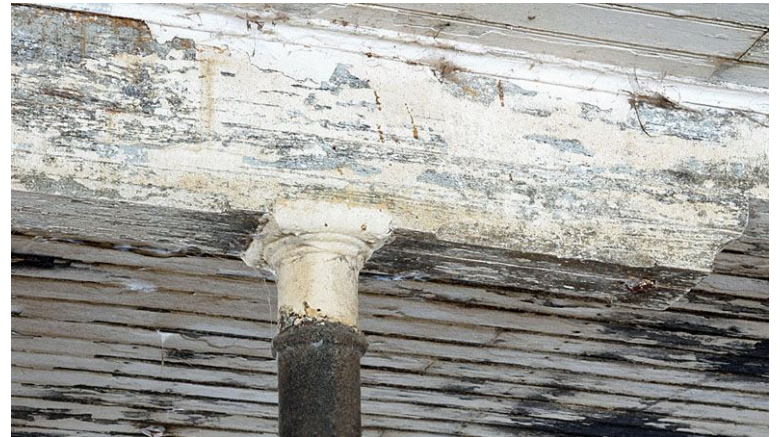
Gjutjärnspelarens kapital och ovanför det ett sadelträ.
