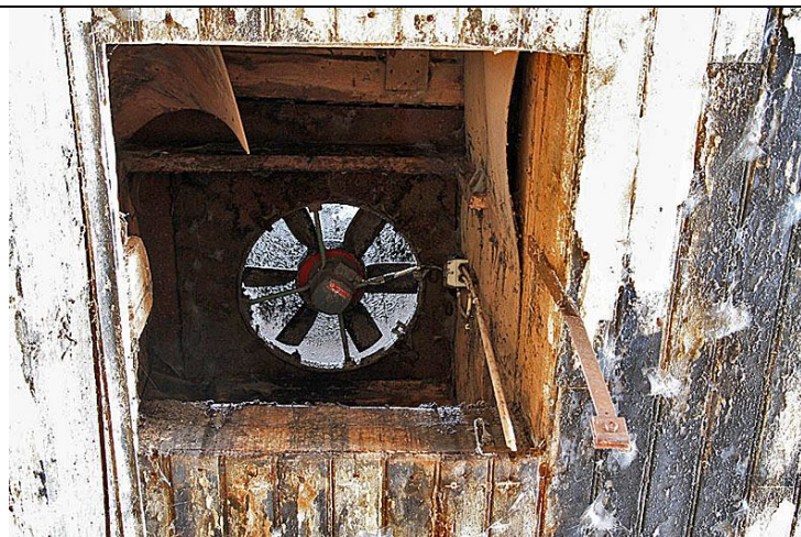
Öppning i ladugårdsrummets tak med fläkt för luftevakivering.
