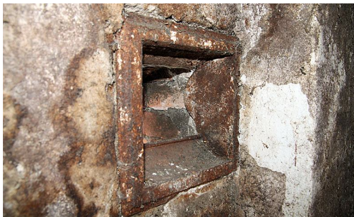
Invändig draggluggsventil i ladugårdsrummet.
