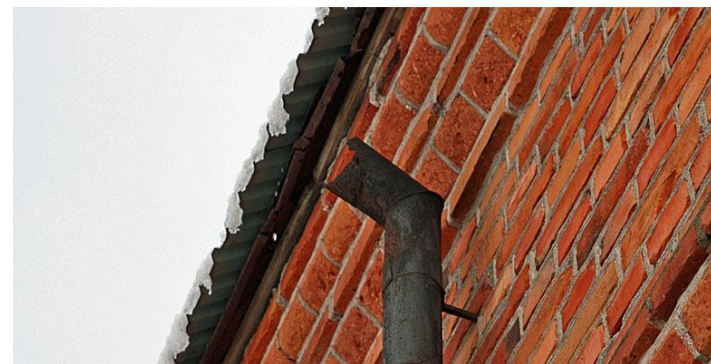
Äldre stuprör utan anslutning.
