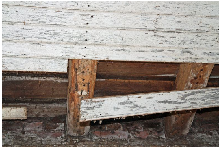
Bjälklagsupplag i tegelmuren
