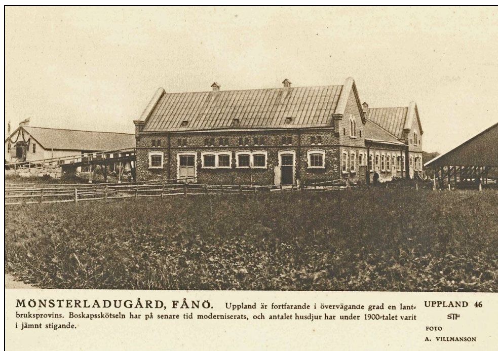
Vykort från 1900-talets början. Bilden är tagen med ortokromatisk film, förmodligen omkring 1910. Taket täcktes med förzinkad stålplåt, ett exklusivt material för ekonomibyggnader
