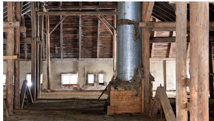
Sekundär ventilationstrumma som mynnar på det sydvästra takfallet.
