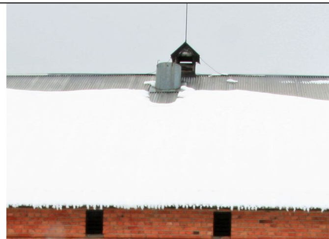
Vid taknock ursprunglig ventilationshuv för skullen och strax nedanför evakiveringstrumma för ladugårdsluften.
