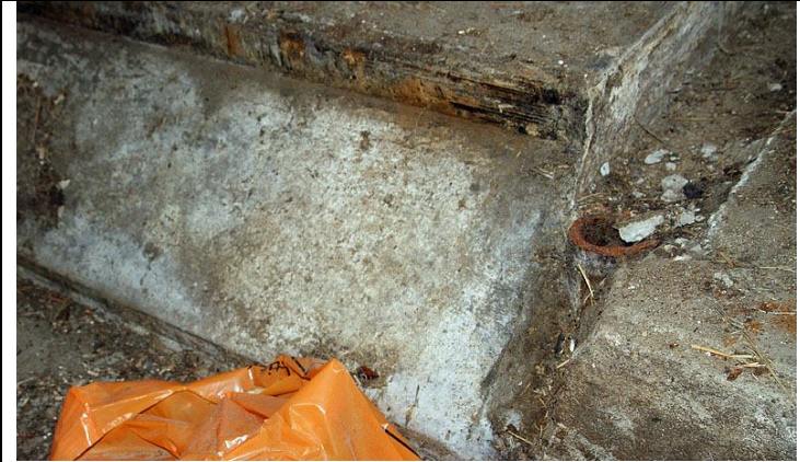
Golv i ladugårdsrummet, sockel och mark i genomskärning. W Steinholz 1891.
