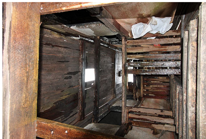
Schaktet till tornens uttagningssluckor.
