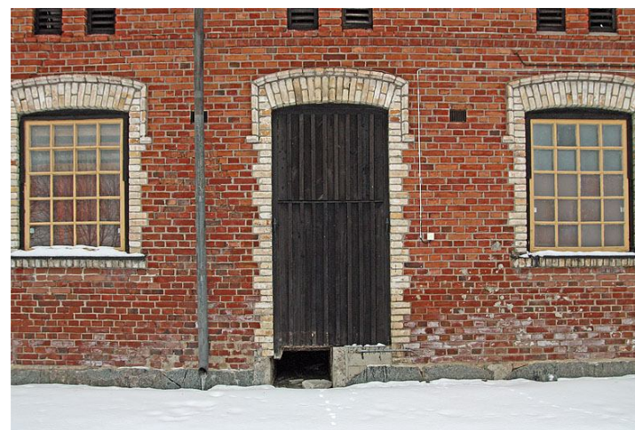
Bräddtäckt dörröppning, d002.
