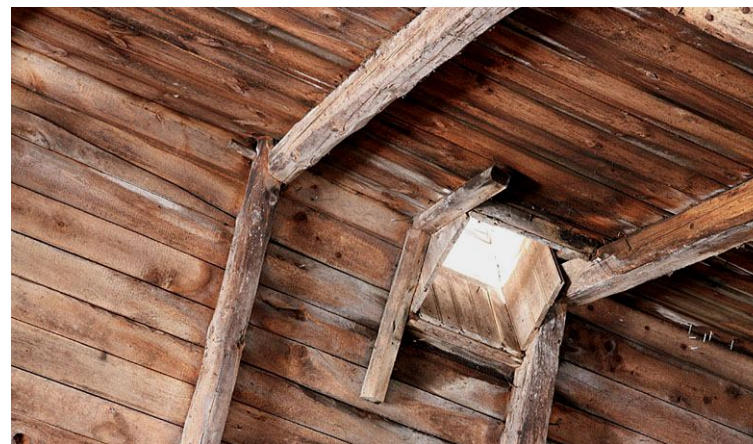
Ursprunglig ventilationshuv i nock.
