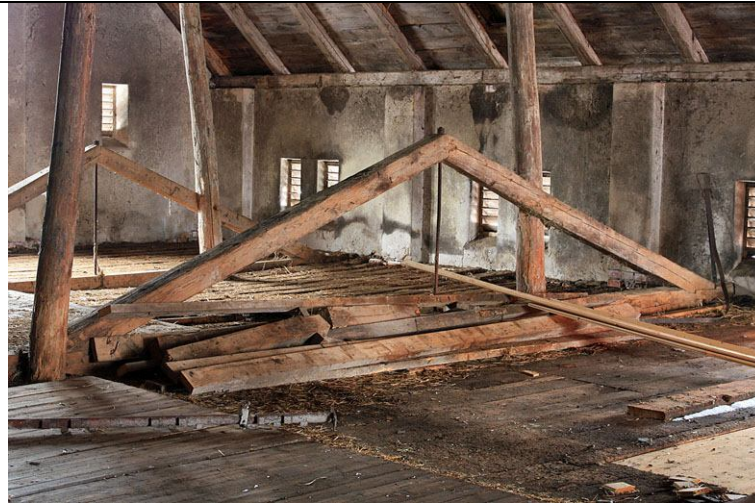
Hängverk i byggnadens nordvästra del.
