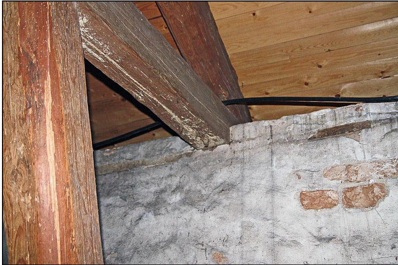
Takstolsupplag på östra fasadens murkrön
