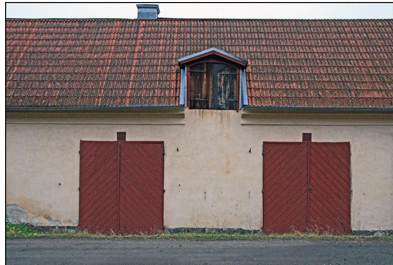
Detalj av västra fasaden med skullutskött
