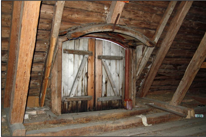
Skullutkott på byggnadens västra sida
