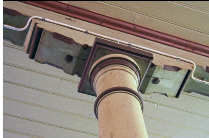
Pelare med kapitäl och konsol i f.d herrskapsstallet
