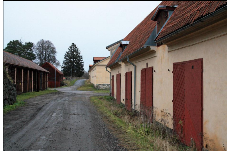
Norra delen av stallängans västra fasad
