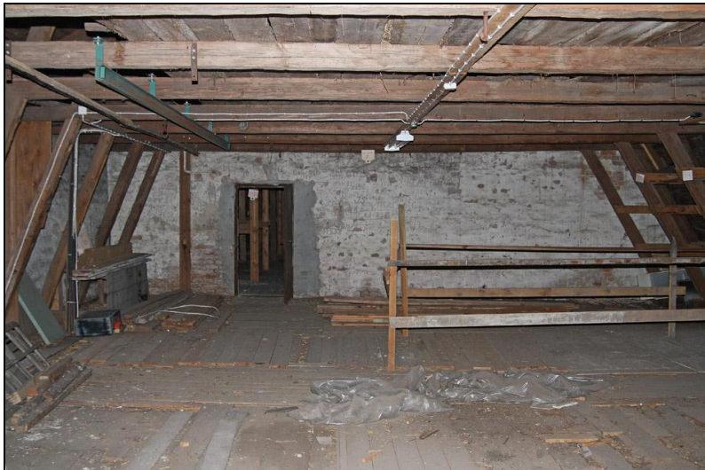
Murad skiljevägg med inskriptioner i putsen mot söder
