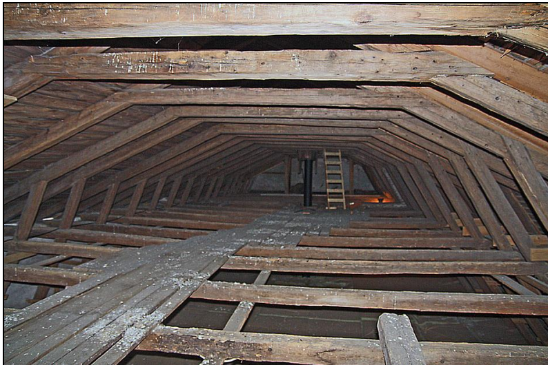
Takstolskonstruktioner i skullens övre plan
