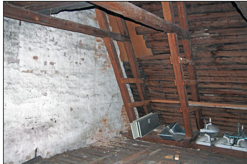
Anslutning mellan skiljevägg och det nedre västra taksfallet
