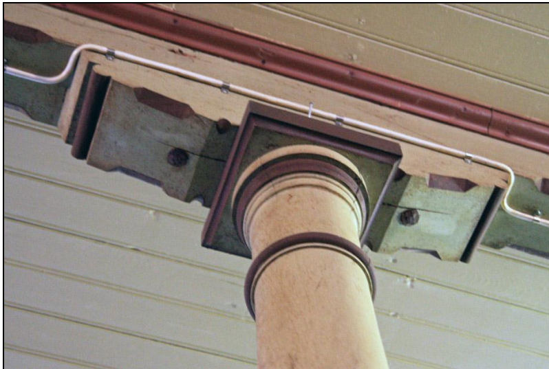
Pelarkapital med konsol i f.d. herrskapsstallet.
