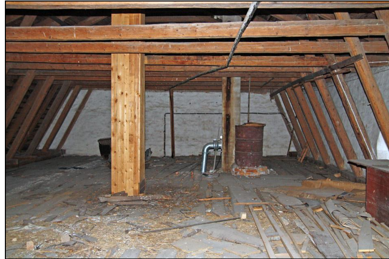
Takstolar, murad skiljevägg och ventilationstrumma mot norr
