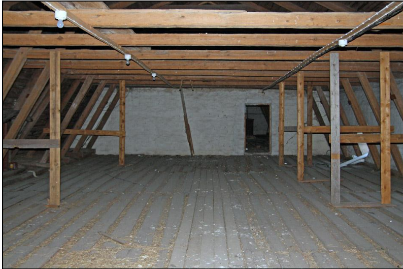
Takstolar och murad skiljevägg mot norr
