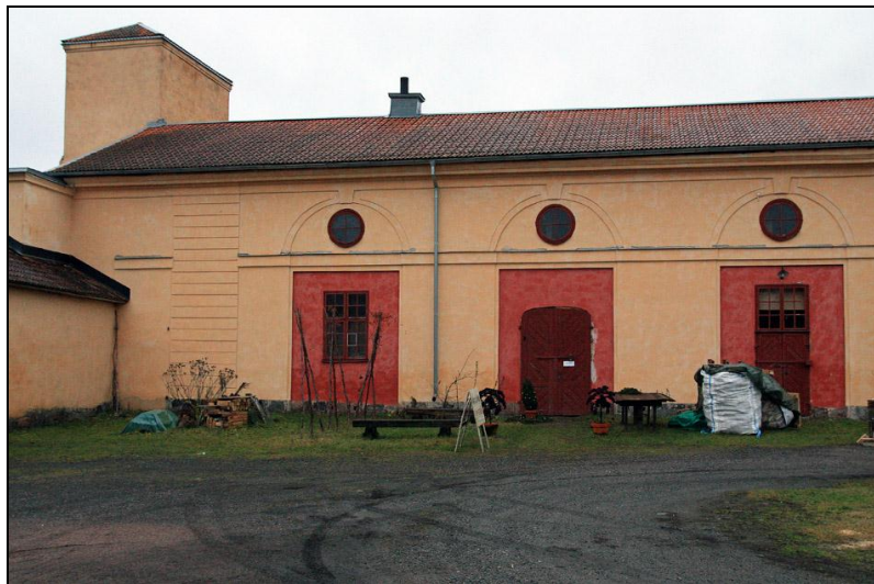
Stallgårdsfasadens södra del
