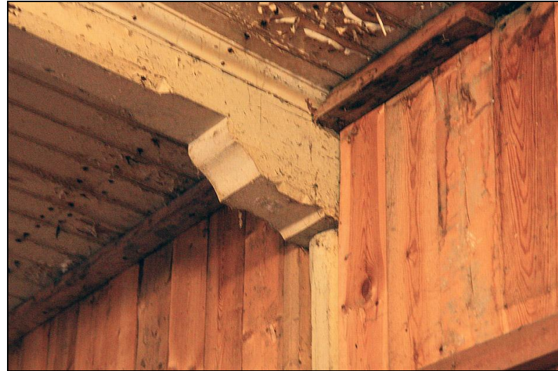
Pelare, konsol och bärlina i f.d. bruksstallet
