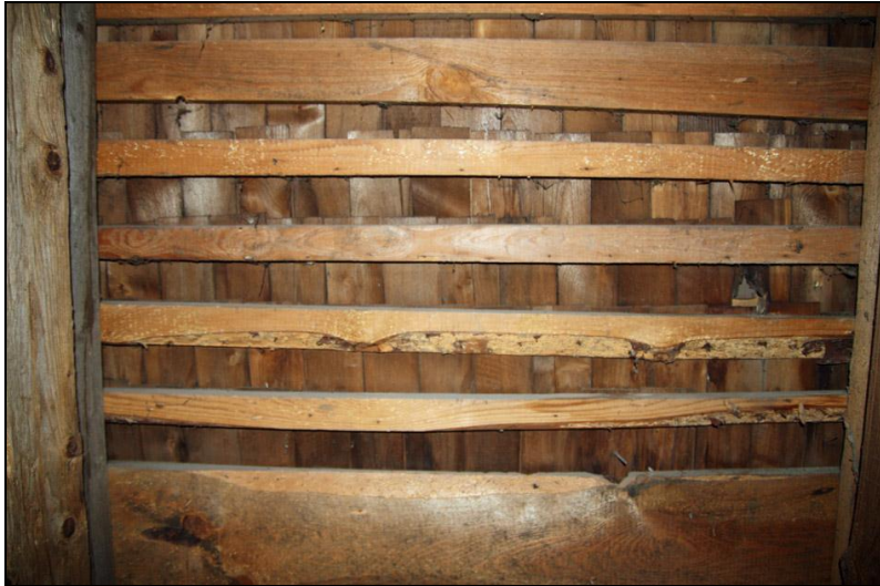
Underak av hyvlat stickspån på västra takfallet
