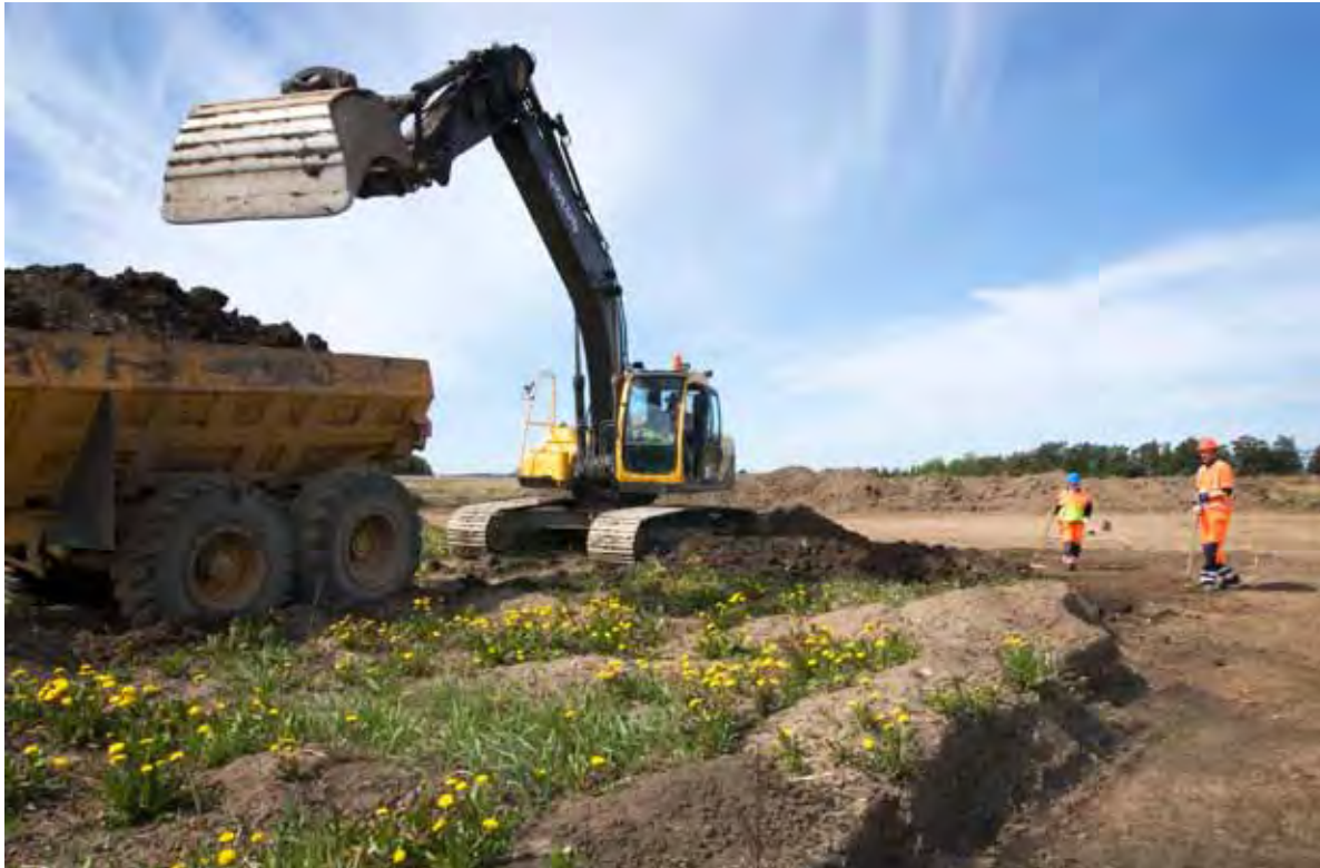
Figur 18 Vid avbaning med maskin prioriteras yta framför eventuella fynd som finns i ploggången. Vid slutundersökningarna anlätades grävmaskinist Ove Lindvall (foto Bengt Backlund, Upplandsmuseet).
