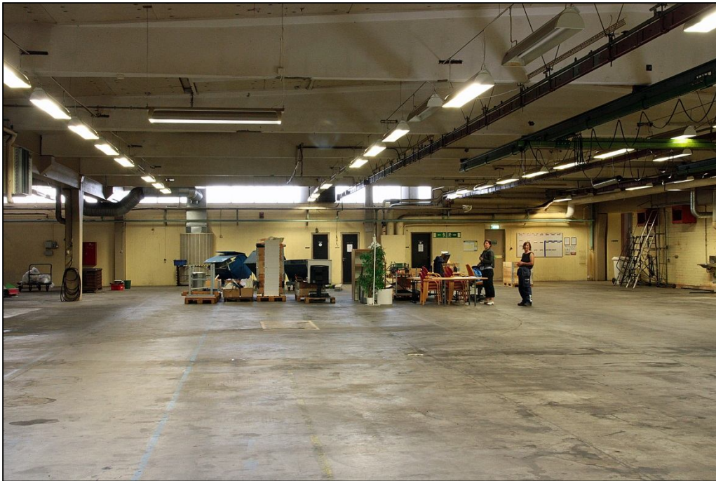
Entresolvåningens vägg mot norr med ljusinsläpp genom ett fönsterband som löper obrutet längs hela fasaden, direkt under takfoten.
