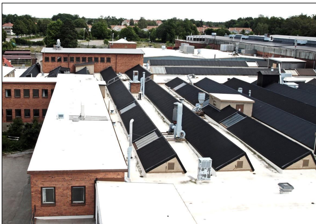
B-verkstadens tak från söder, med de karakteristiska sågtandstaken med ljusinsläpp.
