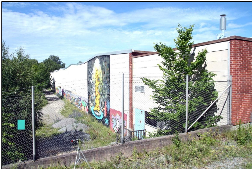
Centrallagrets fasad åt söder. Till höger i bild panncentralen.
