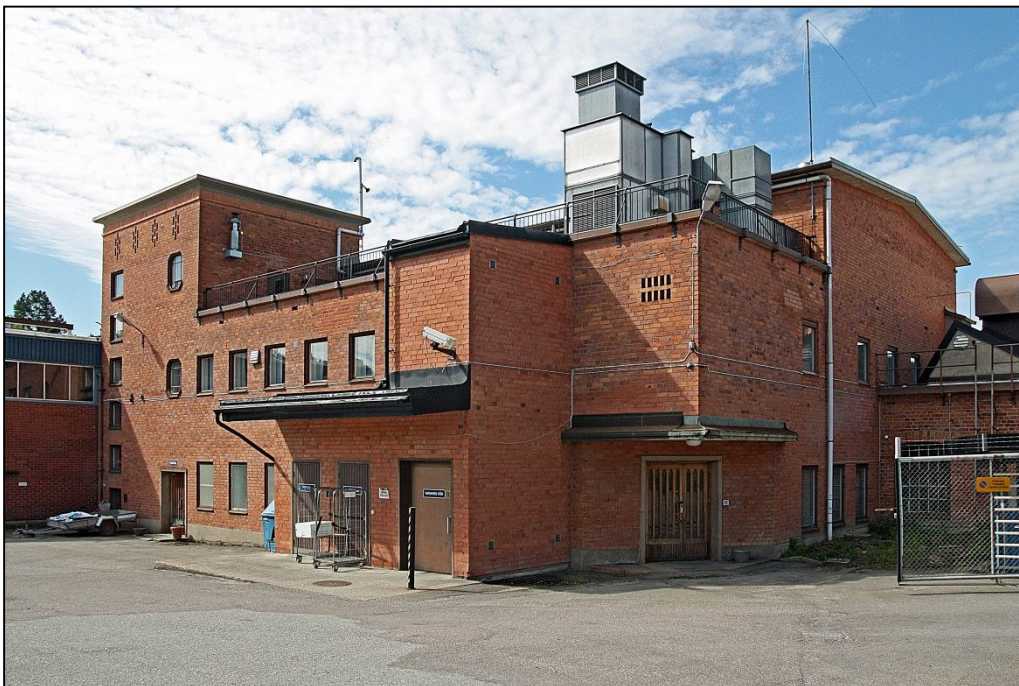
Byggnaden sedd från nordöst, med utskuret entréparti med skärmtak och fernissade, glasade dörrar från uppförandet.
