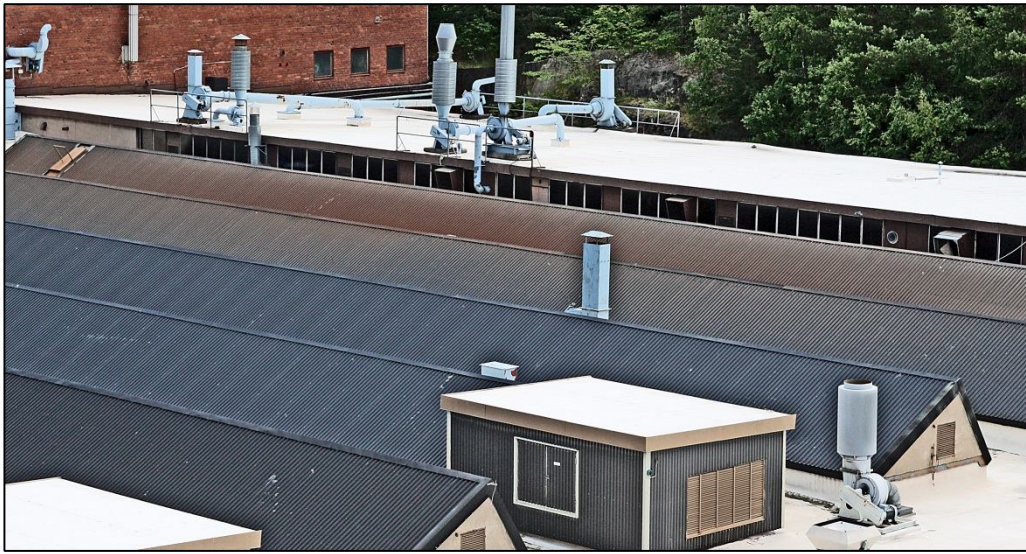
Hårdhusets fönsterband mot norr.
