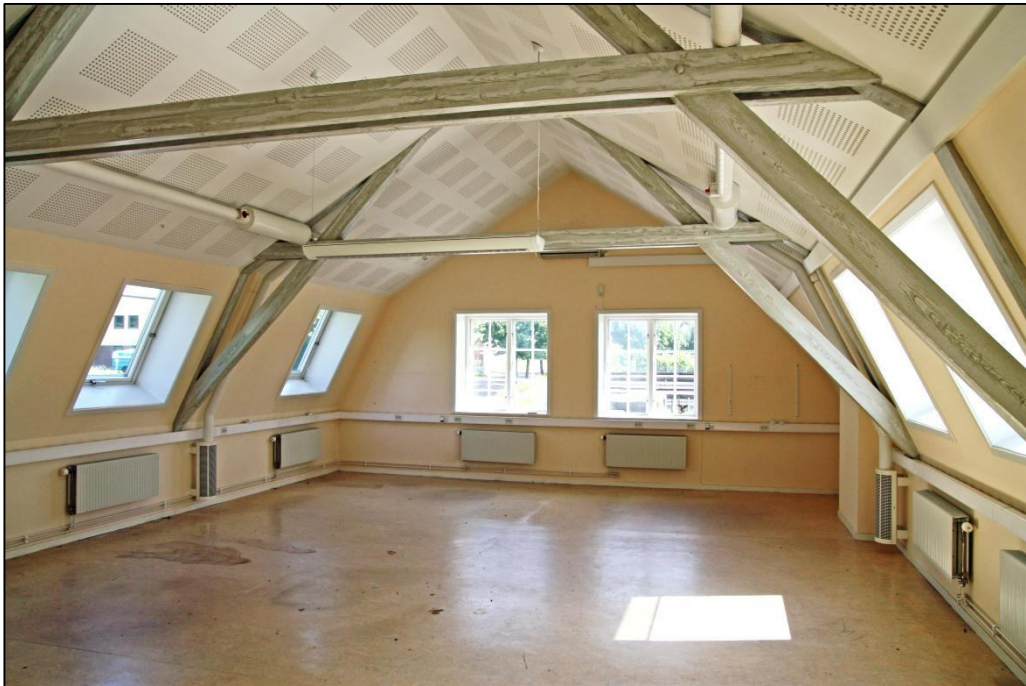
Den ljusa salen på den östra flygelbyggnadens övervåning.
