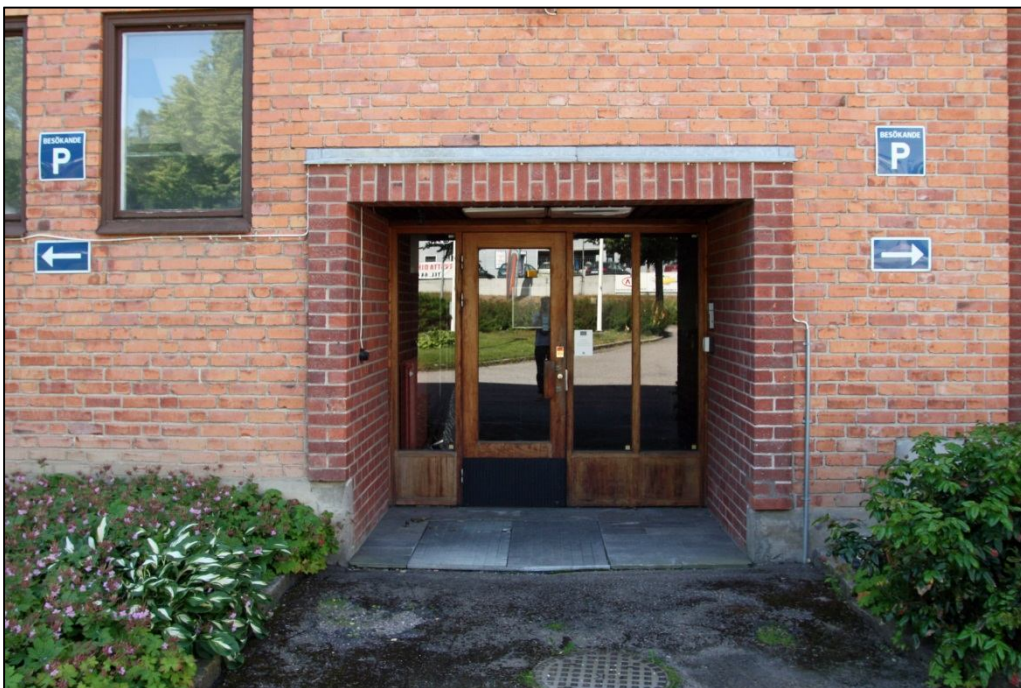
Glaset entréparti med fernissad ek och omfattning i rött tegel.
