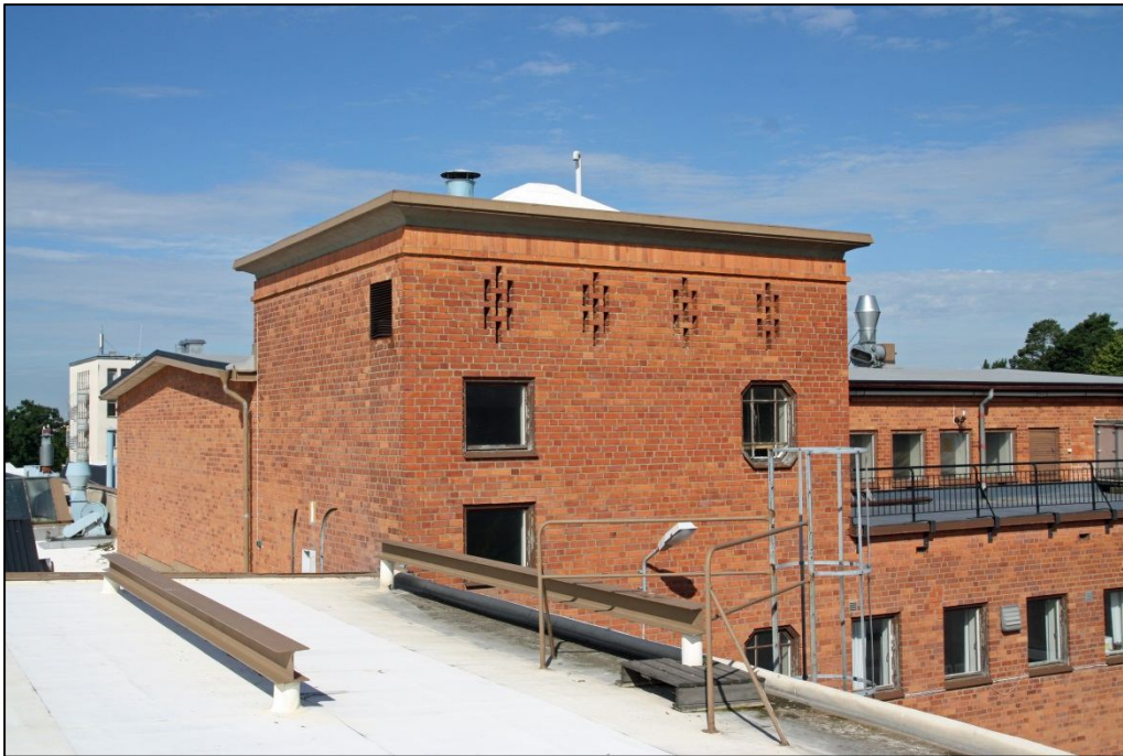
Tornet från A-verkstadens tak. Den röda tegelfasaden är rikt artikulerad med blindingar, takfris och utskjutande takfot med hälkäl samt tidstypiska oktagonala fönster.
