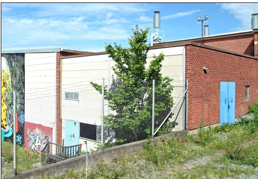
Panncentralen från sydost.
