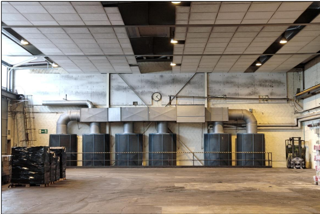
Smedjans gavelvägg mot öster med ventilationsaggregat.
