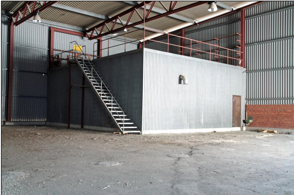
Kallförrådets västra del med avbalkning för plåtverkstad. I denna del av byggnaden är stommen utförd med ett stålskelett klätt med trapetskorrugerad plåt
