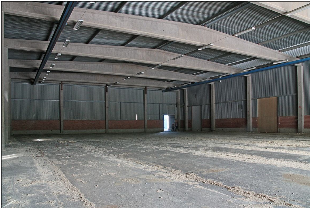
Kallförrådets östra del. Stommen är här utförd med betongpelare och betongbalkar.
