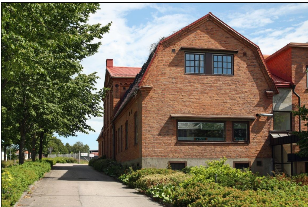
Den västra kontorsflygelns gavel.
