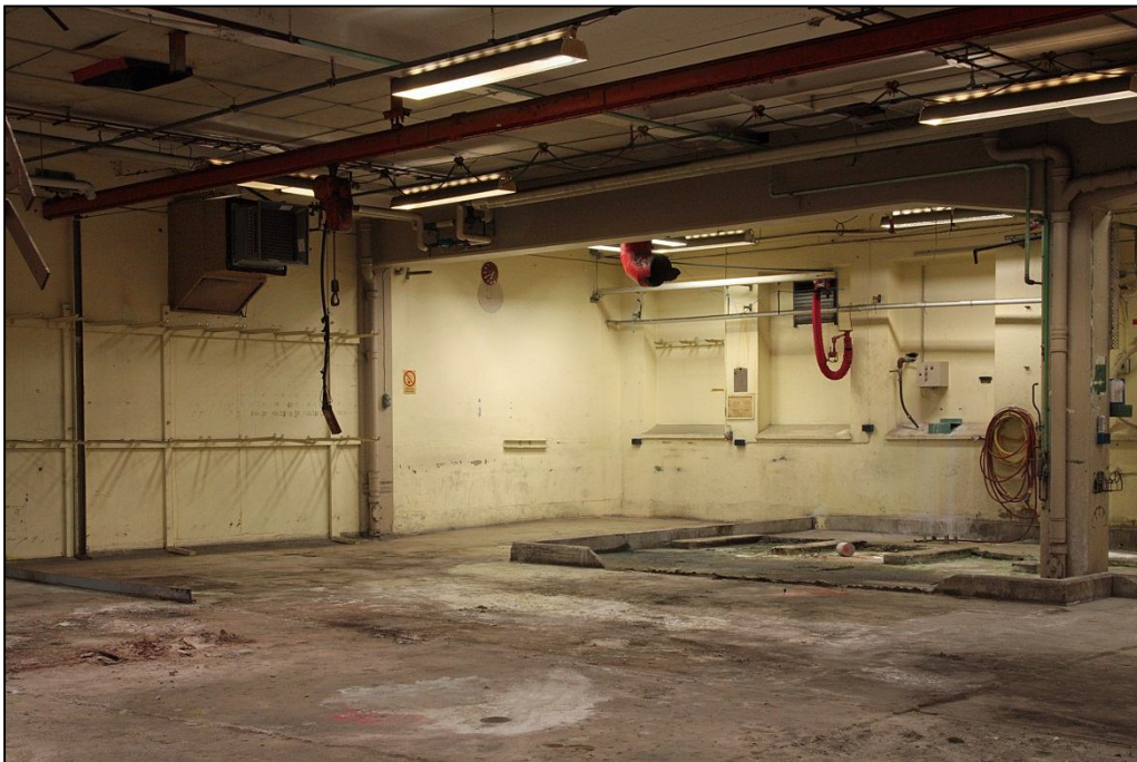
B-verkstadens sydvästra hörn. Till vänster i bild syns portar till det angränsande hårdhuset. Mitt i bild syns spår efter den ytbehandlingsverksamhet som fanns här med bland annat förnickling.
