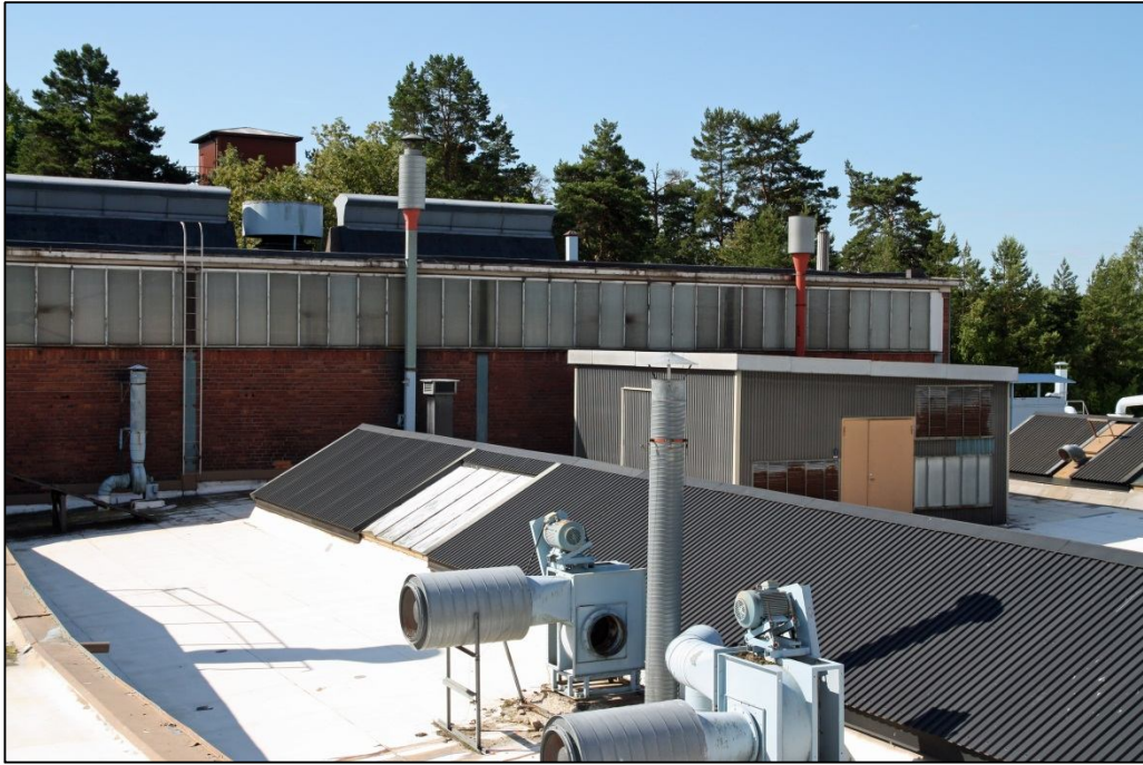
A-verkstaden äldre delen. Takfall med två "sågtänder mellan flacka ytor. Längst till vänster i bild ansluter den nya delen av A-verkstaden, som byggdes till 1974.
