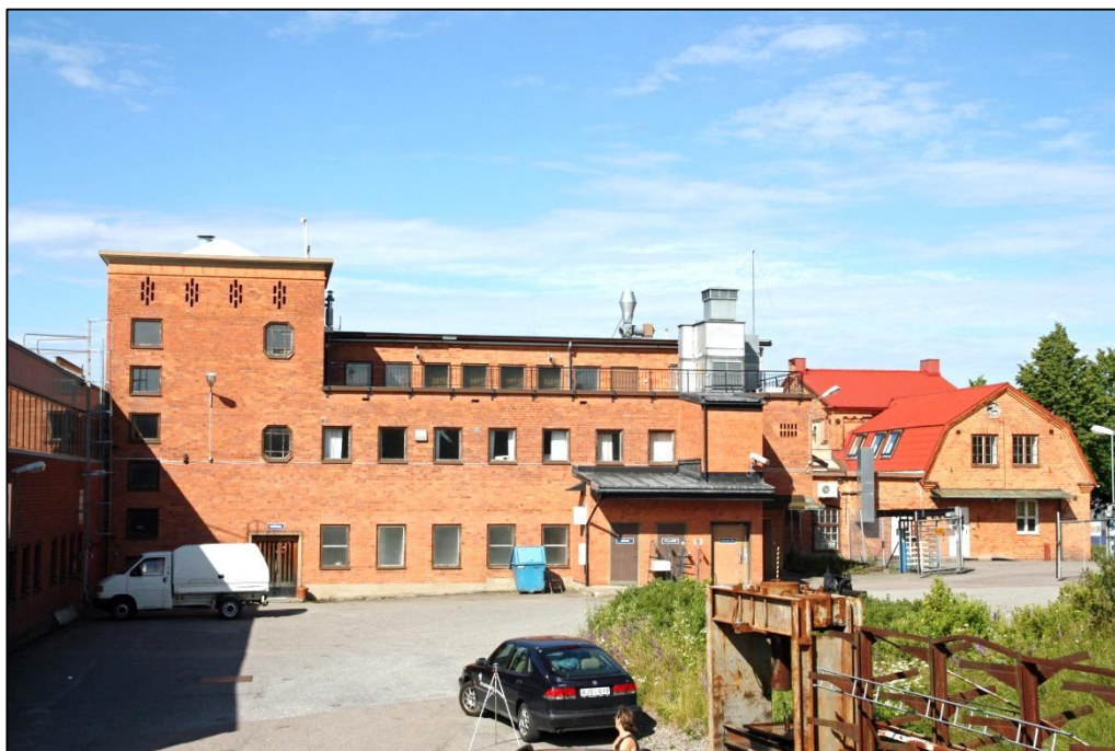
Byggnaden sedd från öster. Längst till höger i bild kontorsflygeln från 1918.
