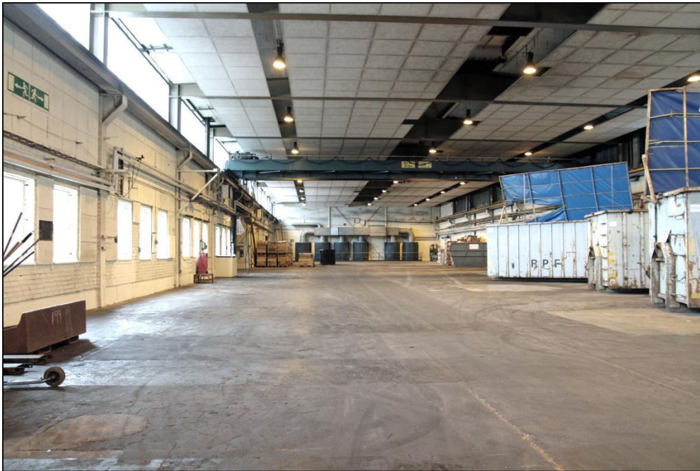
Smedjans östra del med den norra långväggens rad av kvadratiska fönster mot asfaltsplanen framför A-verkstaden.
