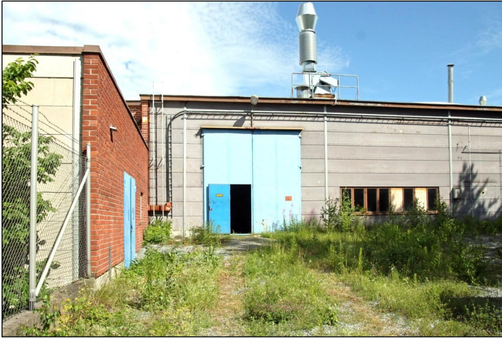
Hårdhusets södra fasad. Till vänster i bild panncentralen.
