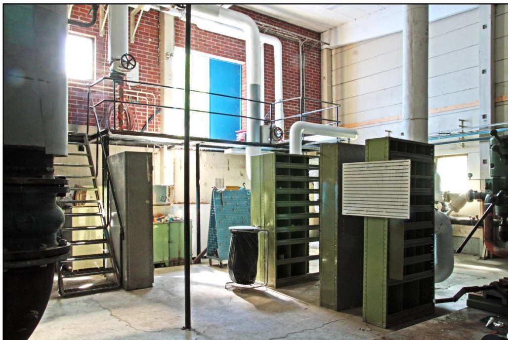
Panncentralens östra vägg med trappa upp till planen framför hårdhuset.
