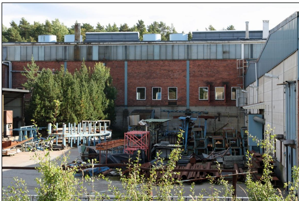
Smedjans fasad mot norr.
