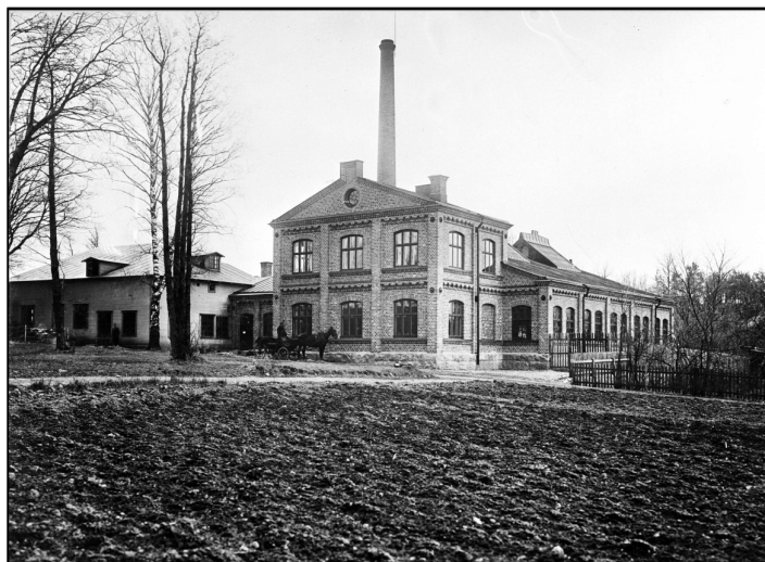
Kontors- och fabriksbyggnaden från 1899 med det 1907 tillbyggda kontorshuset till vänster i bild
