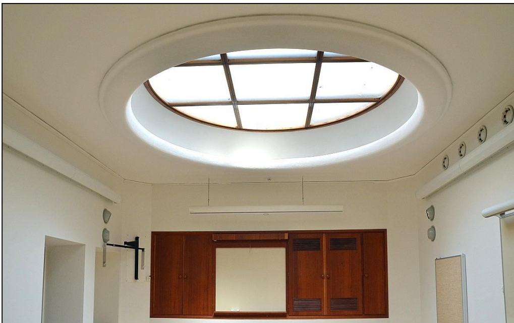
Takfönster i sammanträdesrum i den östra kontorslängan.
