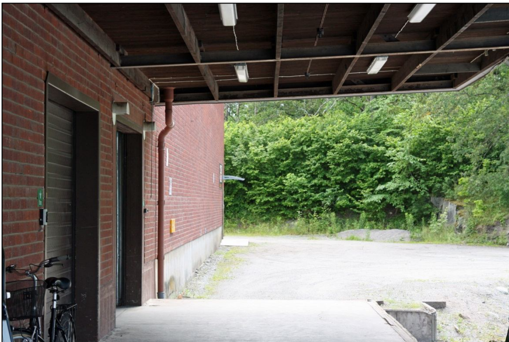
Centrallagrets lastkaj, belägen på byggnadens västra sida..
