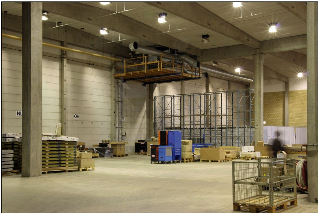
Centrallagrets sydvästra del, som redovisar byggnadsstommens konstruktion med bärande betongpelare, balkar och takstolselement.
