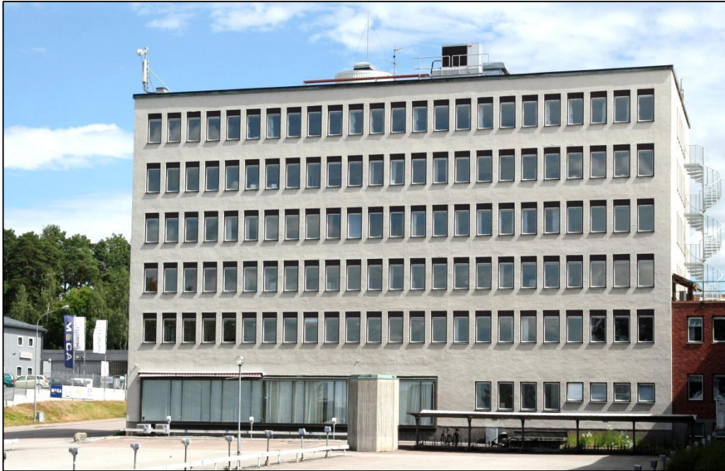
Centralkontoret från väster. Till höger i bild skimtar en lägre tegelbyggnad som förbinder centralkontoret med centrallagret.
