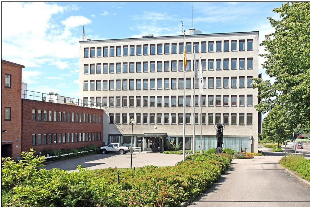
Centralkontoret från öster. Till vänster i bild syns den tvåvåningsbyggnad i rött tegel som förbinder centralkontoret med kontorsbyggnaden från 1948.
