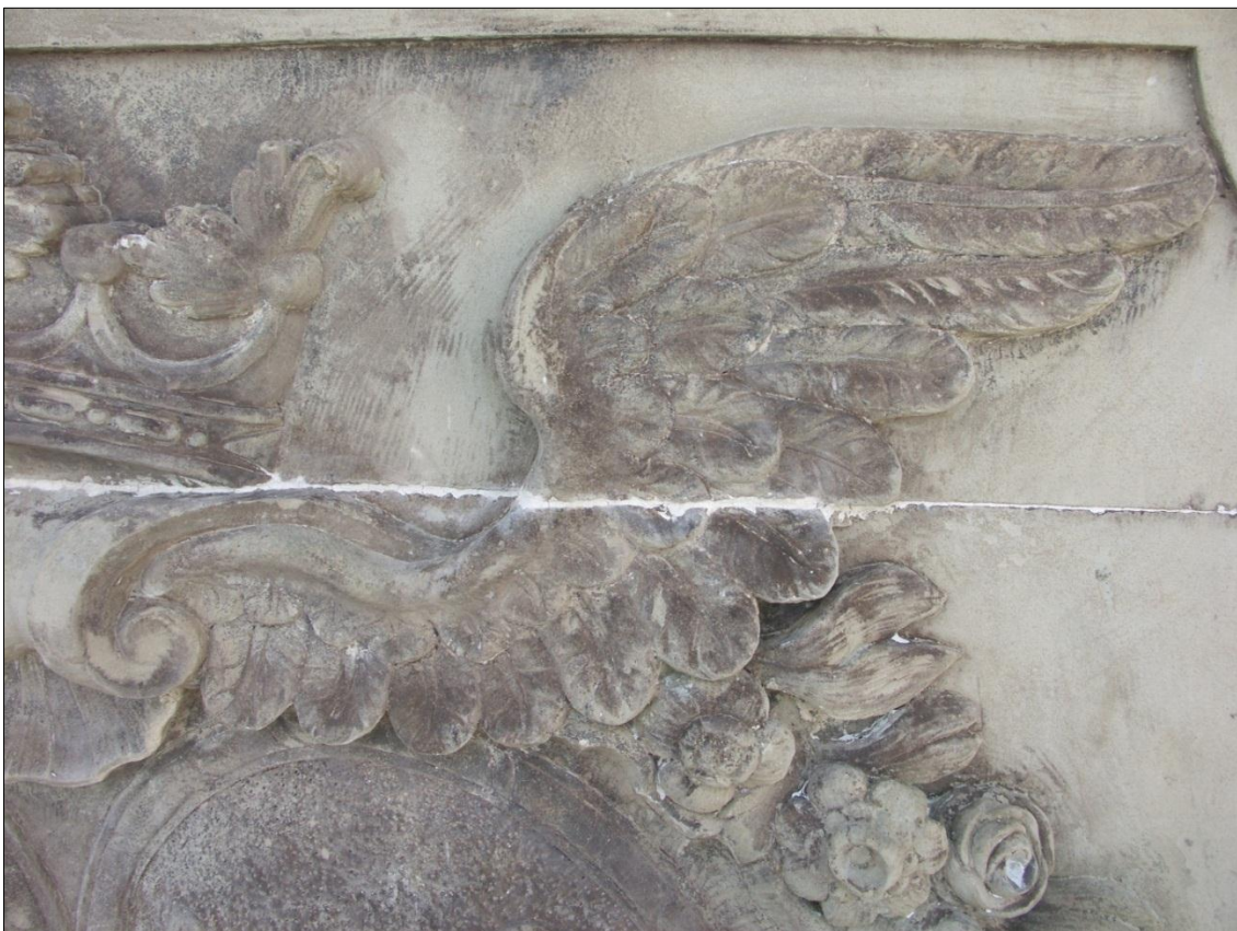
Vapentavlan med svarta missfärgningar, materialförluster och sandning, mot väster, 2012
