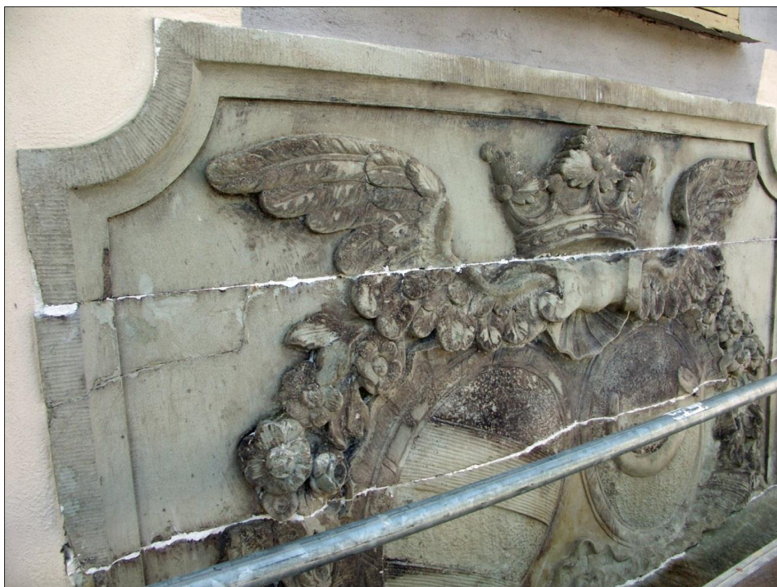
Vapentavlans övre del med de två övre skarvarna mellan sandstensblocken, gipsbaserade lagningar, svarta missfärgningar och materialförlust, 2012
