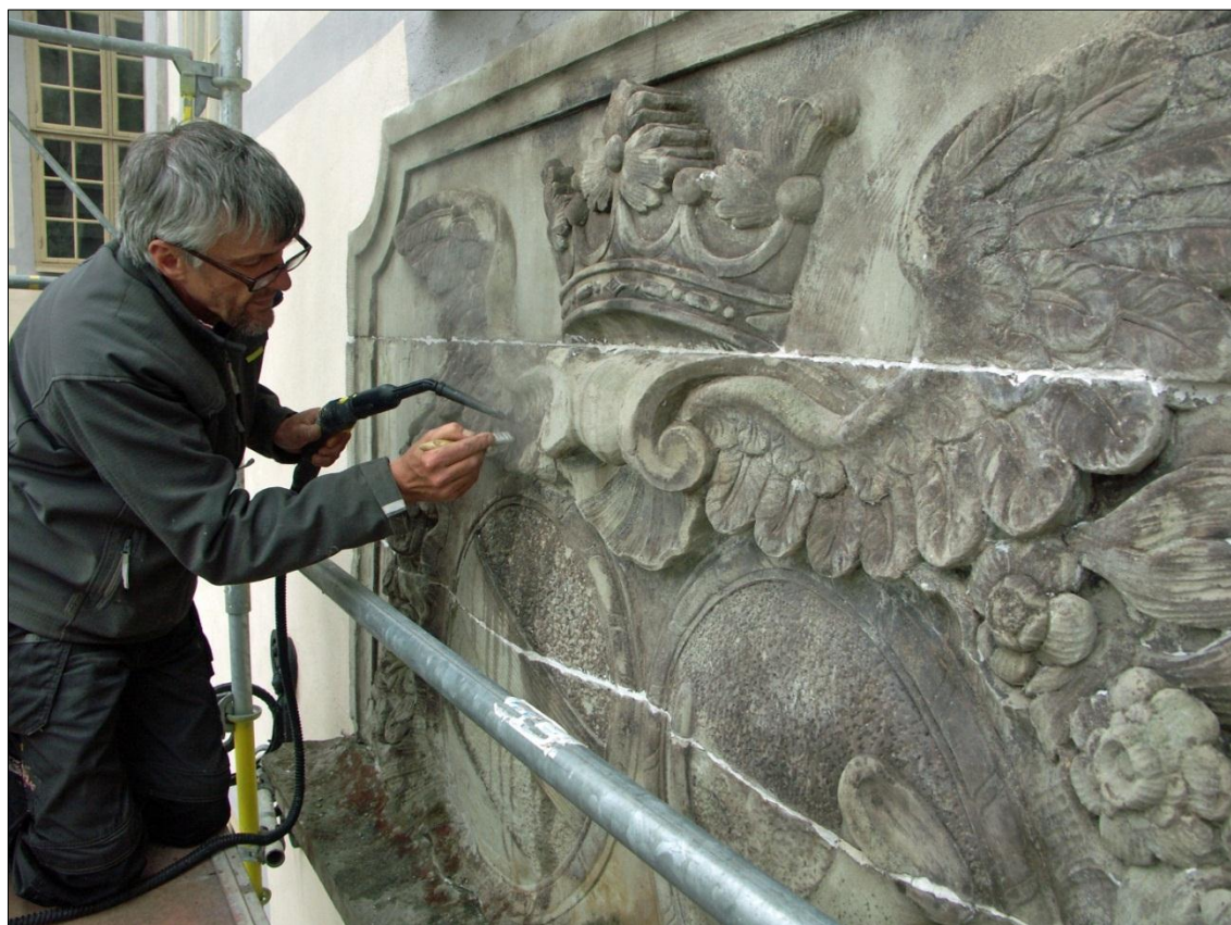
Svante Nilsson rengör vapentavlan med vattenånga och mjuk borste, 2012
