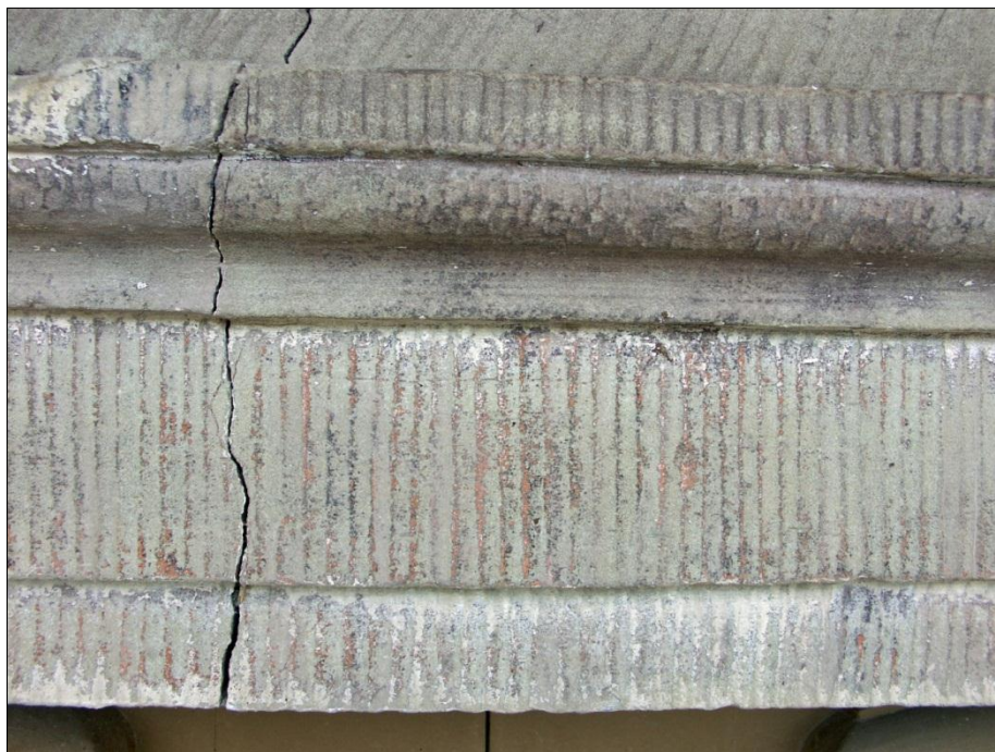
Vertikal spricka i överliggaren, en följd av äldre sättningar i byggnadens stomme, samt spår efter en rödbrun missfärgning, 2012
