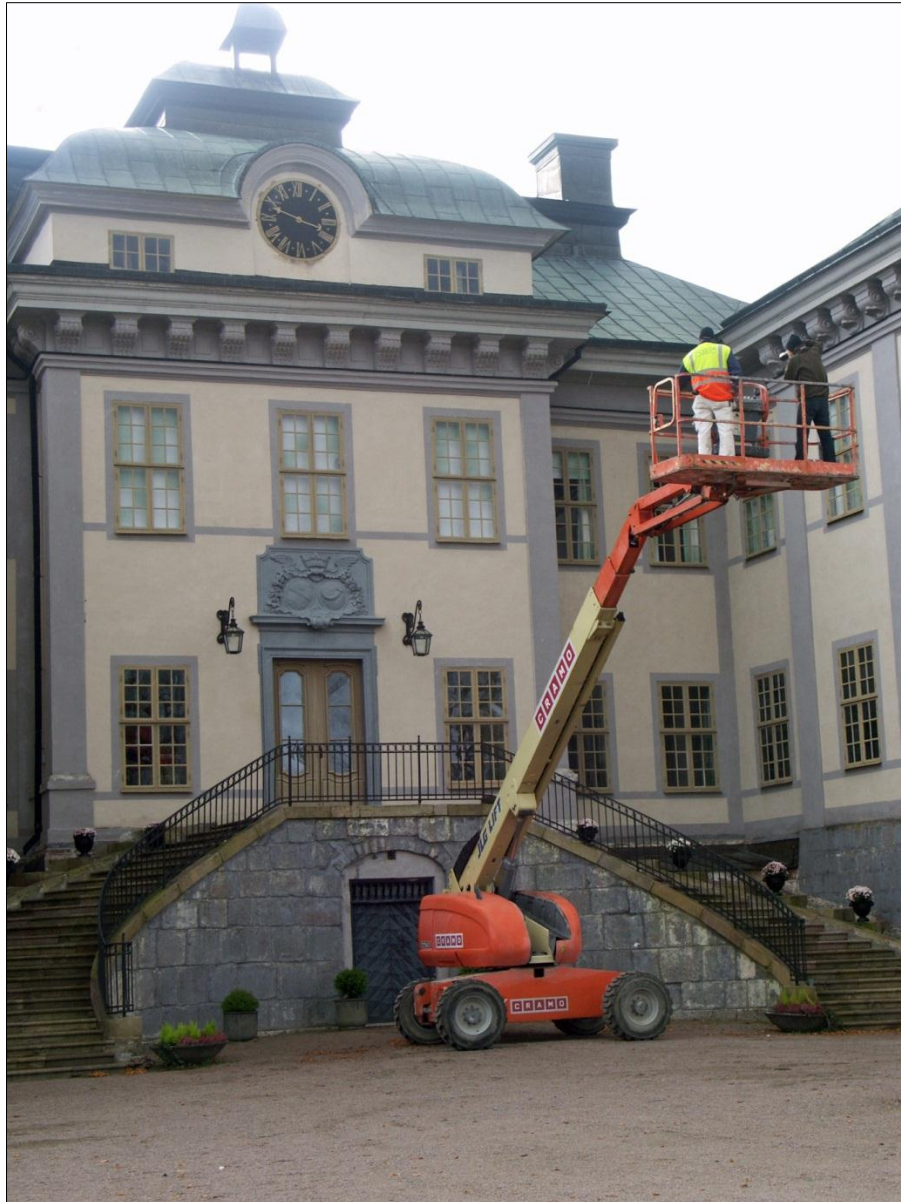
Fotografering av den färdigställda portalen från skylift, 2012
