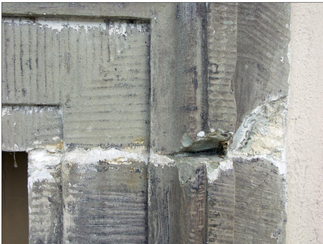
Lågerbuggen omfattning med svarta missfärgningar, materialförlust och gipsbaserade lagningar, mot väster, 2012
