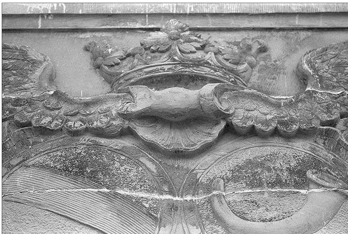
Salsta slotts portal med svarta missfärgningar och tydliga skarvar mellan sandstensblocken, 1992. Foto Lars Kennerstedt (RAÄ, ss920308)
