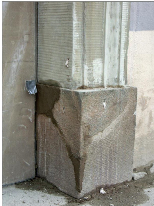
Den bortfallna stenen i sockelstenen mot väster har limmats och stiftats på plats, 2012
