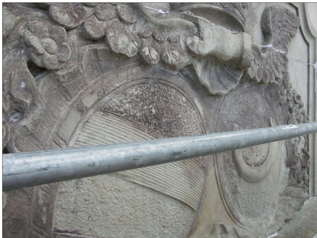
Vapentavlans nedre del med adelsfamiljerna Bielkes och Horns vapensköldar med svarta missfärgningar, materialförluster och sandning i sköldarnas nedre del, 2012
