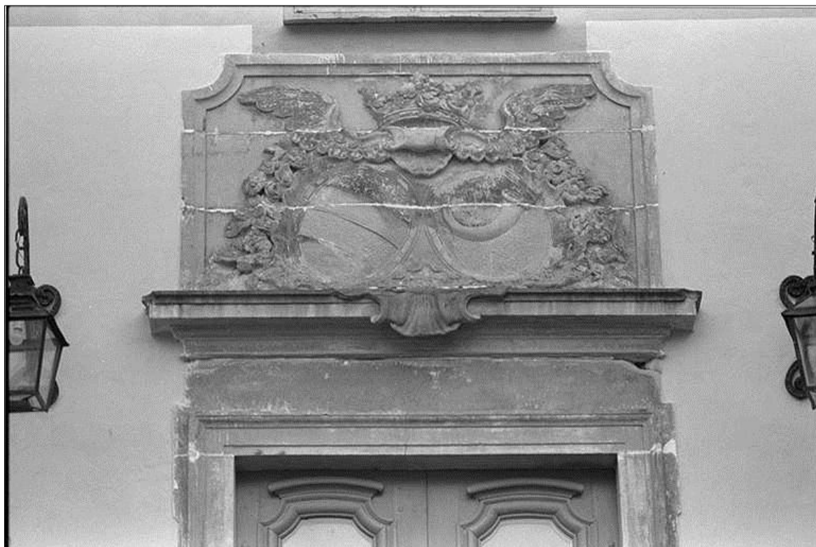
Salsta slotts portal med skador som materialförluster, 1992. Foto Lars Kennerstedt (RAÄ, ss920307)
