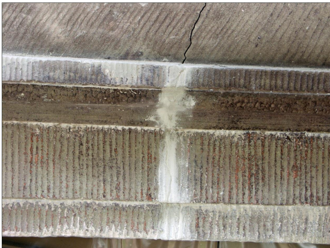
Fogar och sättspricka i överliggaren har lagats i med klebergips, 2012
