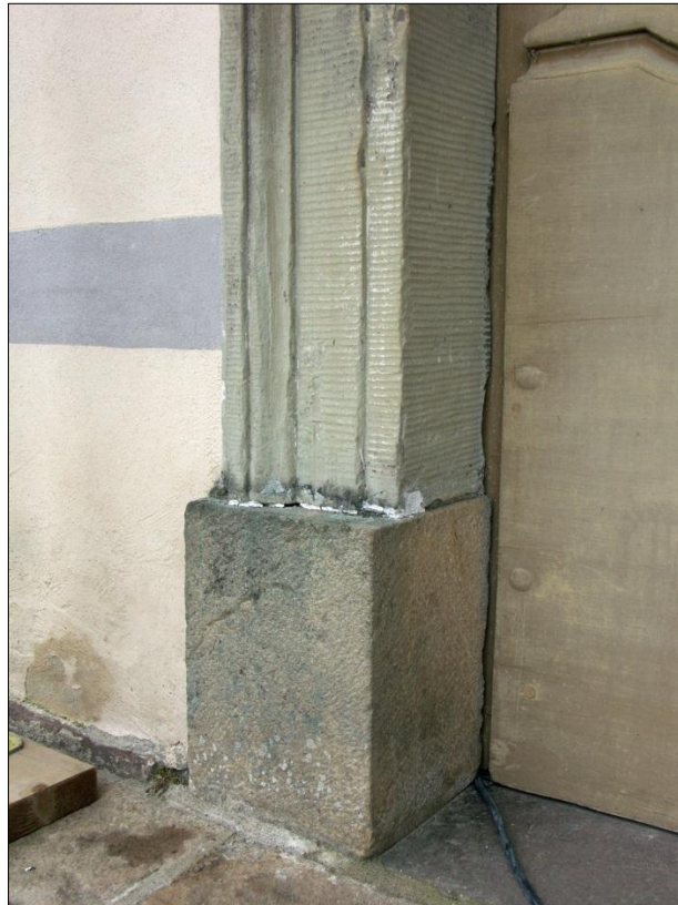
Sockel i roslagssandsten med spricka, mot öster, 2012
