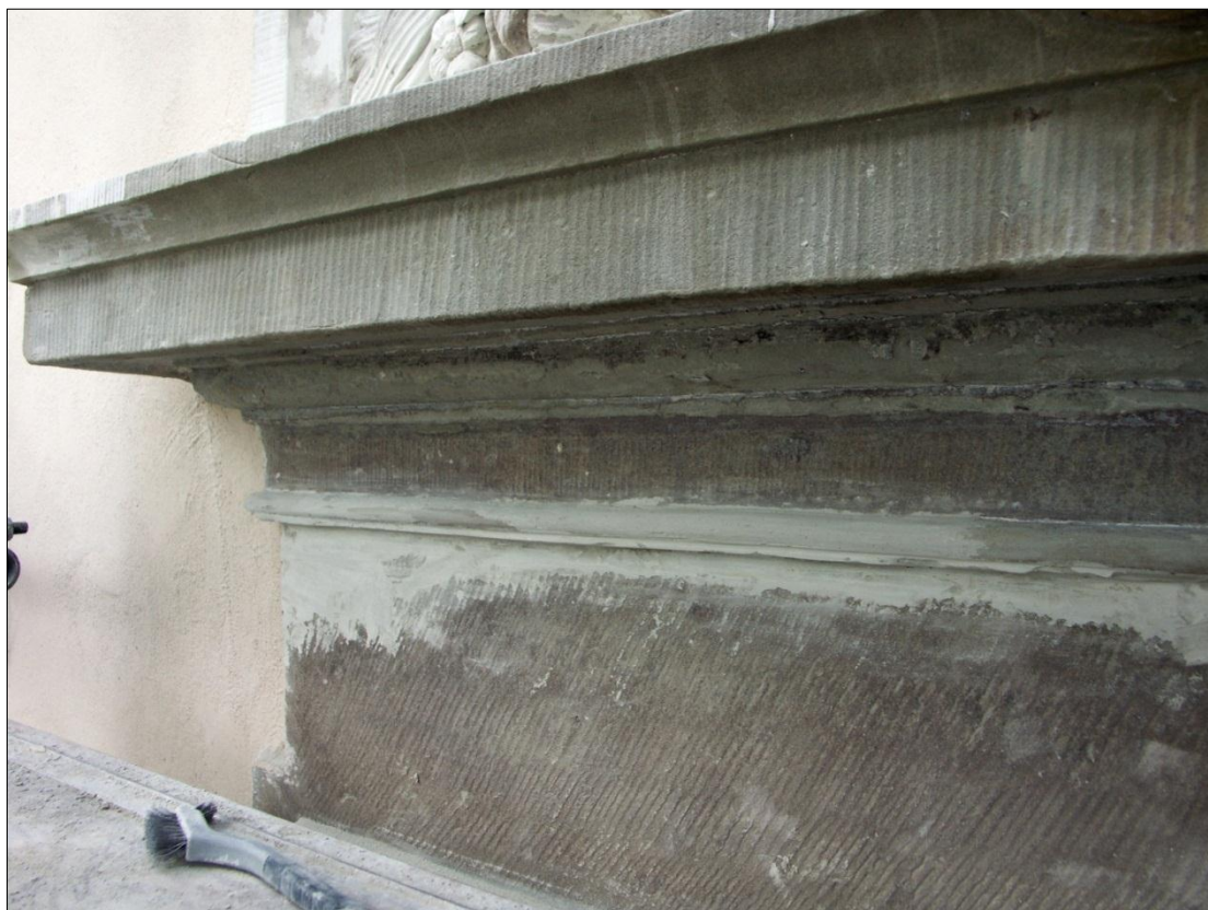
Fogar och sättspricka i överliggaren har lagats i med klebergips, 2012
