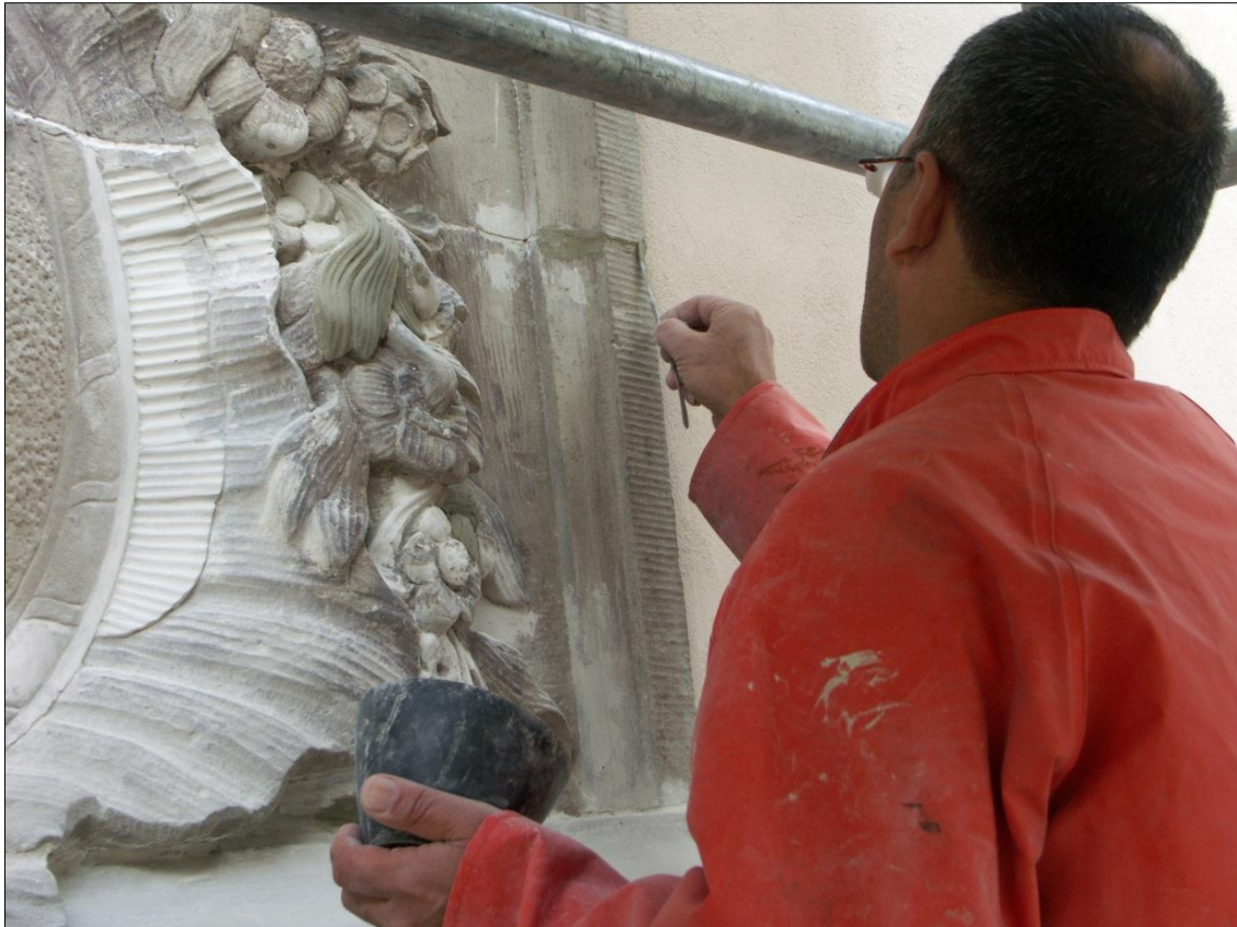
Layth Naqqaer fyller i skarv mellan sandstensblock, 2012
