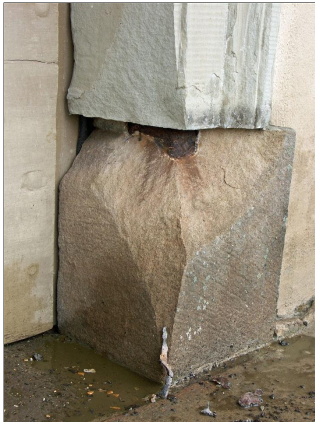
Sockel i roslagssandsten med materialbortfall och rostsprängning, mot väster 2012
