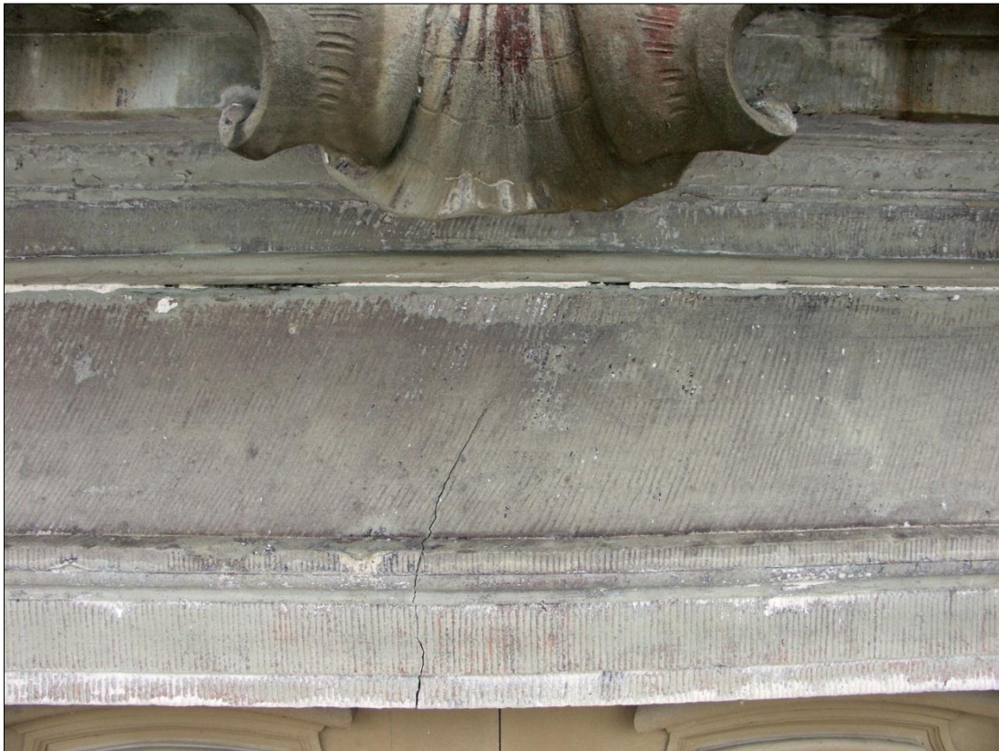
Vertikal spricka i överliggaren, en följd av äldre sättningar i byggnadens stomme, 2012
