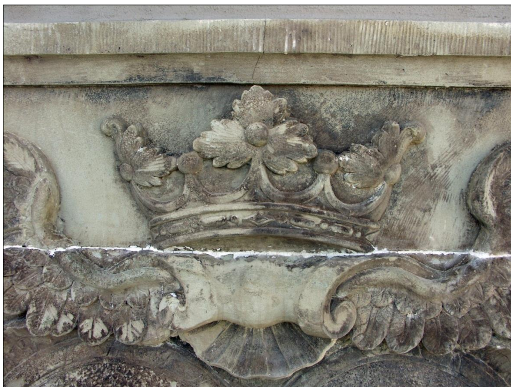
Vapentavlans övre del med den övre skarven mellan sandstensblocken, svarta missfärgningar materialförlust, 2012
