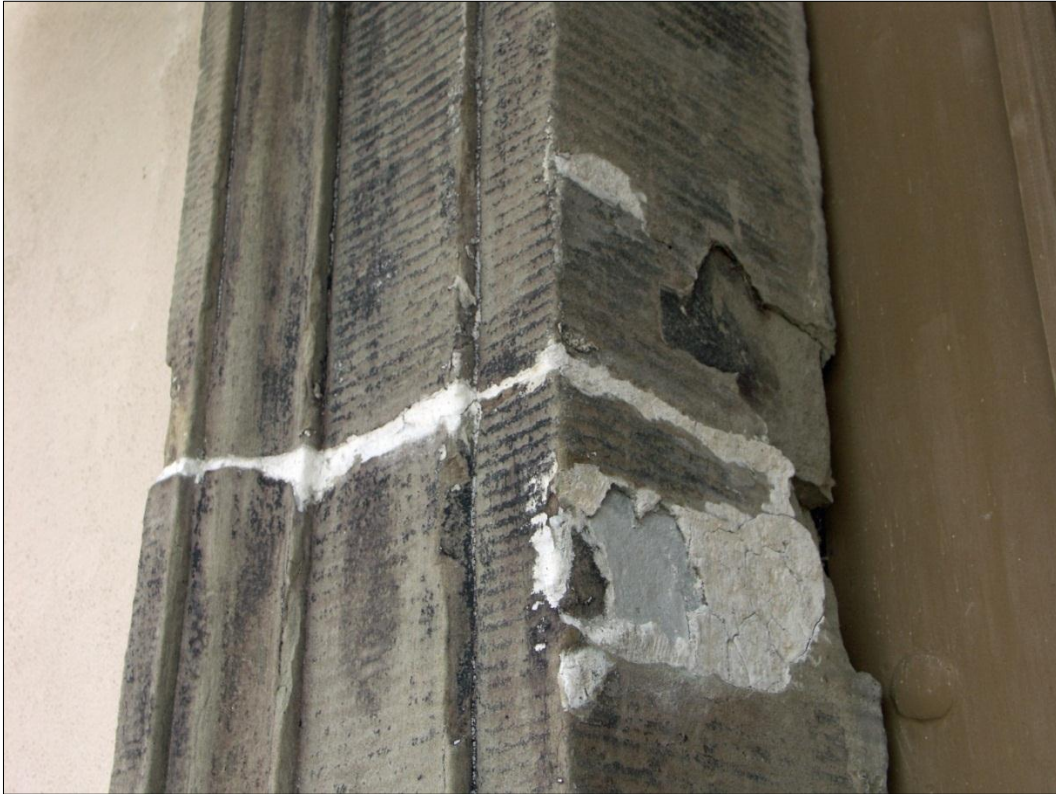
Lågerbuggen omfattning i gotländsk sandsten med bommytorr och sekundära gipserade lagningar, mot öster, 2012
