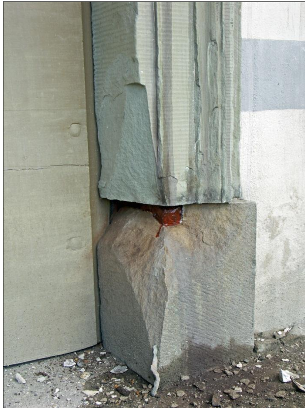
Järntenen i sockelstenen mot väster har rensats och rostskyddsbehandlats, 2012
