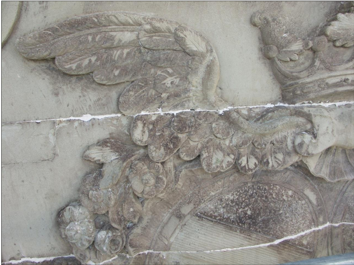
Vapentavlan med svarta missfärgningar, materialförluster och sandning, mot öster, 2012
