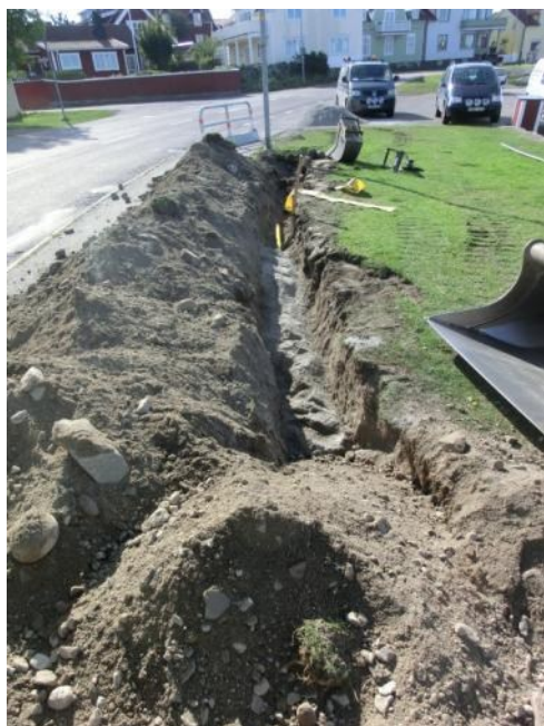
Figur 22. Schaktet vid Södra Hamnplan, mellan fundamentsgroparna A2-7, närmast i bild och A2-8. Foto från öster, 2014-09-17.
