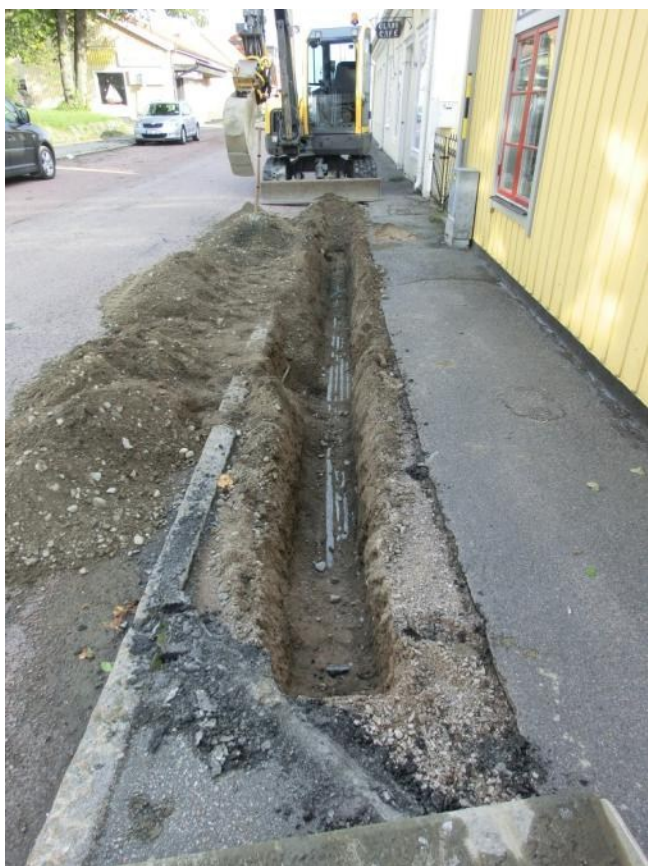
Figur 14. Schaktet på östra sidan av Rådhusgatan, från Kyrkogatan och norrut. I schaktet syns de tidigare nedlagda elkablarna. Foto från söder, 2014-09-24.
