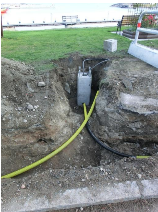
Figur 20. Fundamentsgrop A2-5 i Södra Hamnplan. Fyllningen bestod här av grus och sand. Foto från söder, 2014-09-24.
