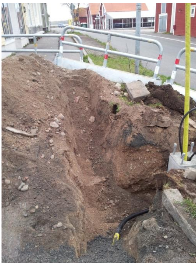
Figur 17. Fundamentsgrop A3-2 i Strandgatan. Även här bestod fyllningen av grus och sand. Foto från söder, 2014-10-17.
