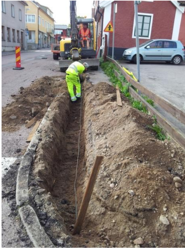
Figur 8. Schaktet under trottoaren på västra sidan av Rådhusgatan. I kanten av schaktet ligger en tidigare nedgrävd telekabel. I bakgrunden intill grävmaskinen placerades fundament A1-5. Foto mot söder 2014-09-10.
