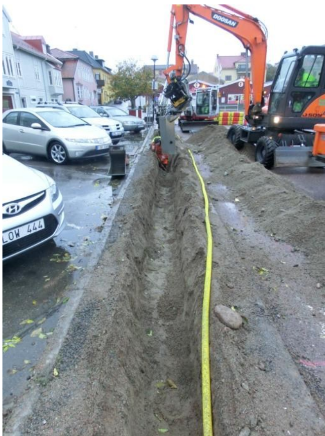
Figur 19. Schaktet i Södra Hamnplan strax intill parkeringsytan. Enbart utfylld sand fanns i schaktet. Foto från öster, 2014-10-08.
