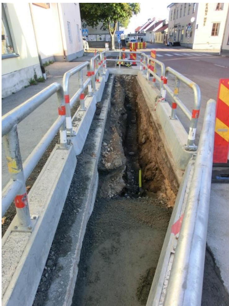
Figur 11. Schaktet strax norr om fundamentsgrop A1-4. På denna plats hade schaktet ett djup av ca 1 m under markytan och det var vid denna plats som sektion 1 dokumenterades. Foto från söder, 2014-10-01.
