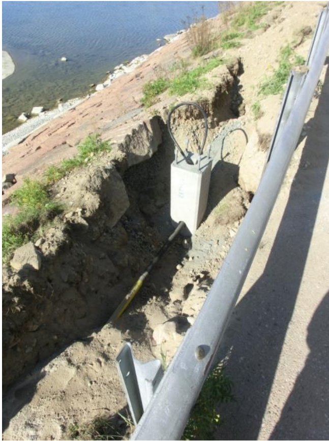
Figur 23. Fundamentsgrop A2-10. Foto från söder, 2014-09-17.
