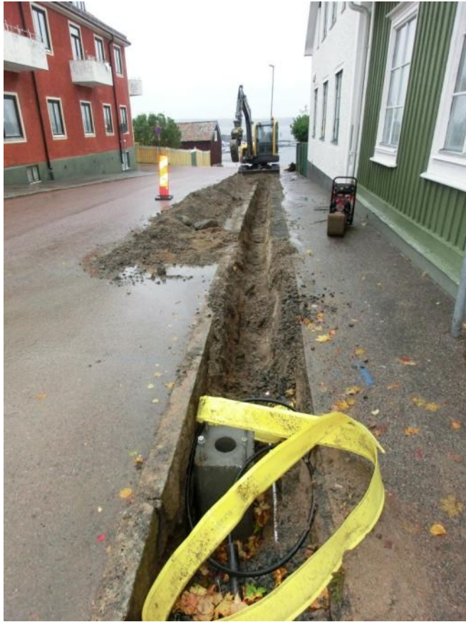
Figur 15. Schaktet på östra sidan av Rådhusgatan, i slutet av gatan ner mot Sjötullsgatan. I schaktet syns de tidigare nedlagda elkablarna och placeringen av ett stolpfundament. Foto från söder, 2014-09-24.
