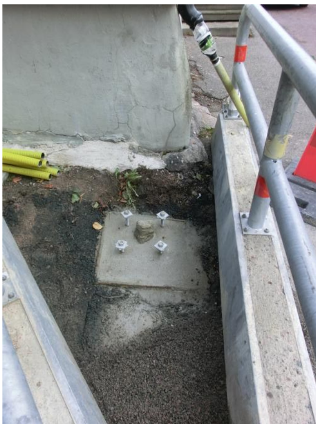
Figur 13. Det platsgjutna stolpfundamentet intill hushörnet (biblioteket) i korsningen Kyrkogatan – Rådhusgatan. Foto från söder, 2014-09-24.
