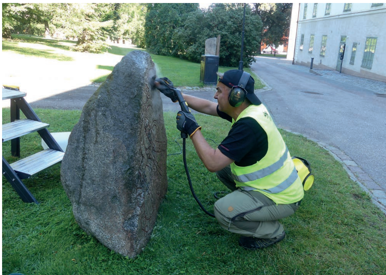
Robin Lucas använder ett ångtvättsaggregat för att rengöra U 939 i Universitetsparken i Uppsala. Foto Malin Lucas, Upplandsmuseet.
