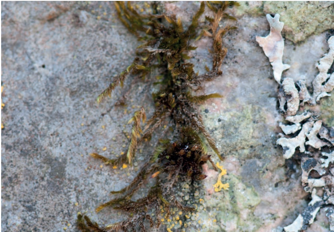
Detalj av ristningsytan på U 686. Mitt i bilden sitter en mossa som växer i sprickan mellan sten (till höger) och en cementlagning (till vänster). På stenytan finns en tunn grön slöja av grönalger. Gula prickar på cementen är skorplavar som trivs på kalksten, som liknar cement. På stenytan finns en liten bit gul bladlav som ramlat ner från en aspgren och nu växer på stenen. Till höger i bilden växer en grå rosettlav, en bladlav som också migrerat från asp. Foto Eva Ernfridsson
