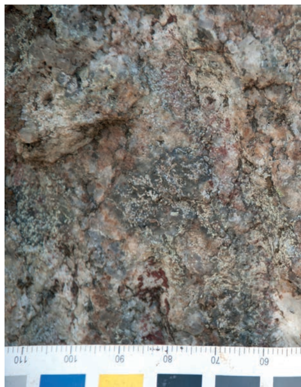
Detalj av ristningsytan. Stenen utgjordes av bestod av grovkornig gnejsgranit med korn mer än 2 cm i diameter. Det finns många lösa bitar av korn, sprickor och avspjälkningskanter. Foto Eva Ernfridsson.
