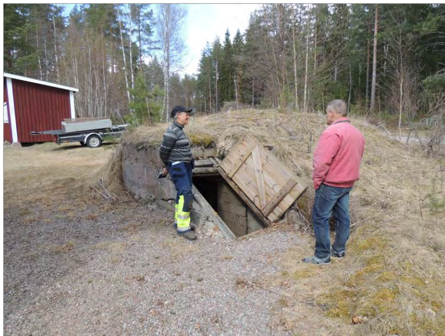
Figur 41. Jordkällaren vid hus 3. Ulf Karlsson upplyste oss om att den byggdes på 1920-talet och att anledningen hade varit att det var för långt till den gamla källaren. Till vänster om Ulf står Torun Zachrisson. Foto Linda Qviström/Upplandsmuseet.
