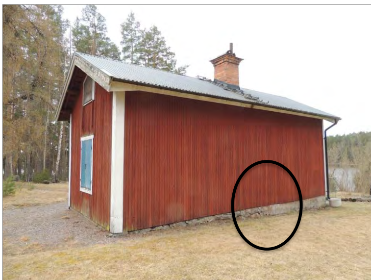
Figur 3. Baksidan av huset våren 2022. I grunden syns en tydlig skarv som troligen tillkommit vid utbyggnaden på 1920-talet. Cirkeln markerar gränsen mellan tillbyggnaden till höger och den äldre stugan till vänster. Foto Linda Qviström/Upplandsmuseet.
